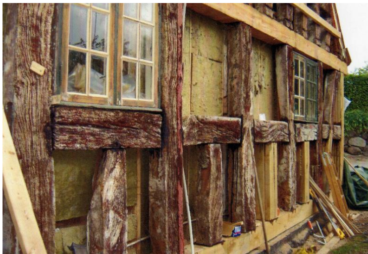
Restaurering af bindingsværksgavl
