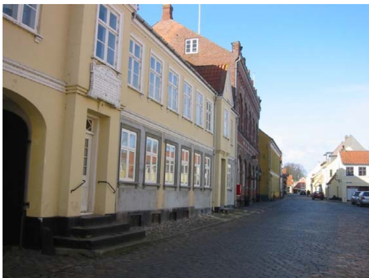
Rekonstruktion af tidligere forretnings- ejendom i Ærøskøbing til beboelse.
