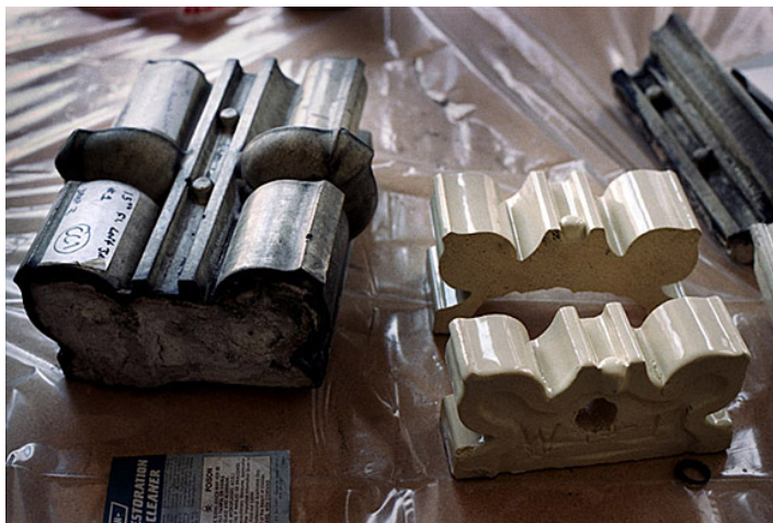
Nye terracotta-elementer til 'The Reliance Building' i Chicago fra 1895, regnet for Verdens ældste 'skyskraber' af stål, glas og terracotta
