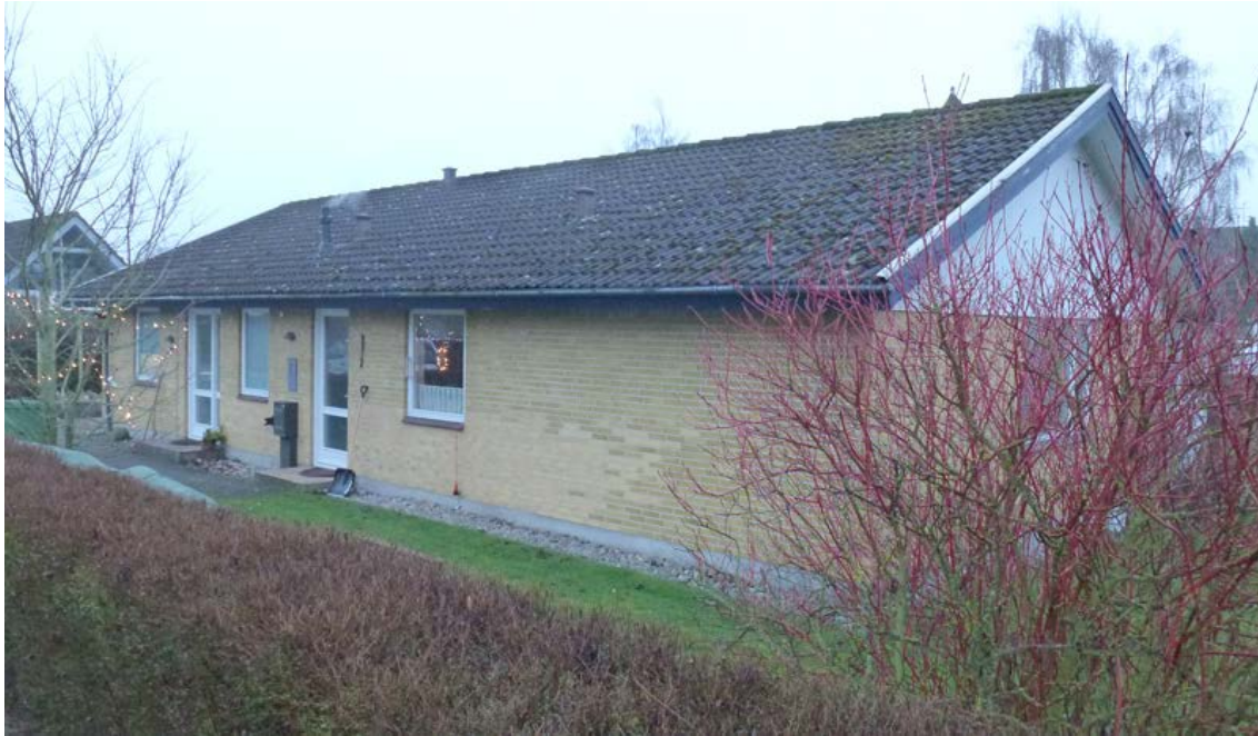
Typisk dansk parcelhus i gule sten – det ser ud til at en del af skalmuren allerede er skiftet ud med nye sten
