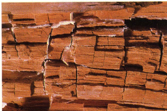
Brunmuld med opklodsning. Hvid tømmersvamp
