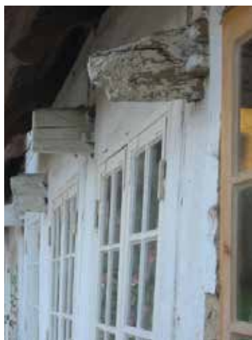
Styrtrumskonstruktionen er let at se udefra via de gennemstukne bjælketappe, der stikker ud i bindingsværksfacaden
