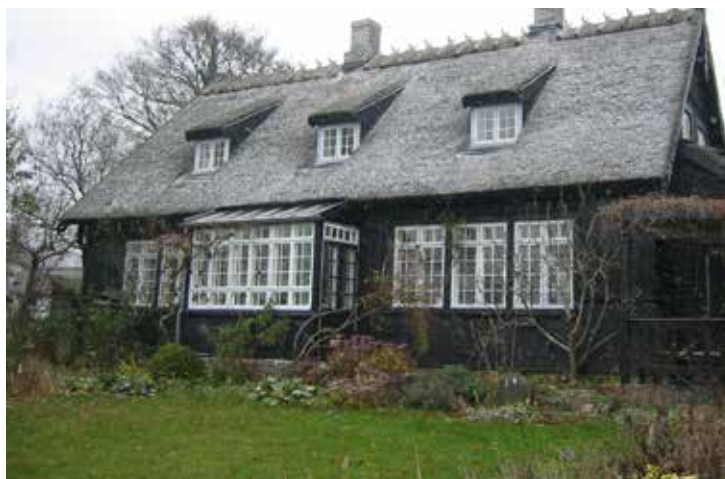
Kviste må ikke være for store og dominerende og skal derudover især have slanke sider for at passe godt til ældre huse. Der må maksimalt være 20 cm mellem kvistvinduet karm og hjørnet på kvist-flunkene.
