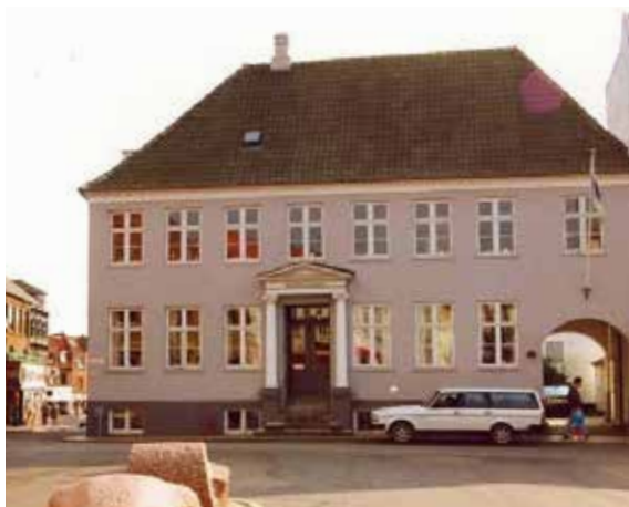
Aabenraa, Storetorv 9, Redergården, opført mellem 1785 og 1787. Fredet
