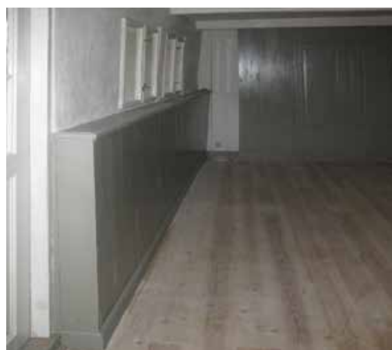
Brystningsisoleringen set i to stadier. Her, hvor bindingsværkstavelene består af soltørrede lersten sættes der blot afstandstråde for at fastholde det ventilerede hulrum, idet lerstenene også er gode til at regulere fugten.
