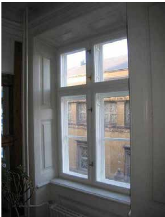
Da lejlighederne har forholdsvis store vindues- og glasarealer, kommer energiforbedringen til at få stor betydning for lejlighedernes samlede varmeforbrug.
