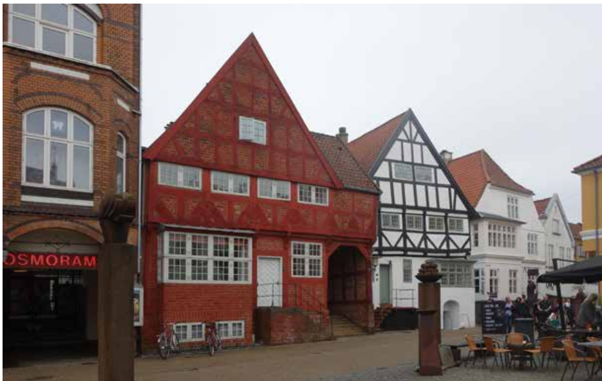
De 1.3 mio bygninger i Danmark, der er ældre end 1960, skal behandles med andre materialer og andre metoder end yngre bygninger. Ikke mindst de cirka 70.000 bindingsværksbygninger, hvoraf mange er over 300 år, men hvor træet rådner, hvis de bliver malet med plastikmaling.
