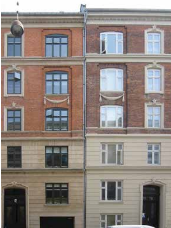
Når man skifter de gamle 'frederiksbergvinduer' ud med nye termovinduer, reduceres dagslysarealet næsten altid markant og dermed den sublime dagslyskvalitet, der er et af dette vindues kendetegn. Husejerne, rådgiverne og vinduesproducenterne til sammen har åbenbart ikke forstået, at egenskaberne og formålet med disse vinduer er at skabe det bedst mulige dagslys i rummene, bl.a. gennem den store, faste midterude.
