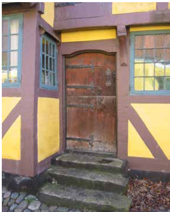
Danmarks næstældste dør, den ældste sidder lidt længere henne ad samme gade i Årøskøbing, er fra 1699. De oprindelige egetræsplanker er malet med okseblod, men det er nu næppe derfor, den har holdt så godt. Den er først og fremmest gennemtænkt og solidt bygget, så træet ikke rådner.
