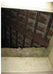
Isoleringen af loftrummet med almindelig mineraluld og et velbevaret understrøget tag
