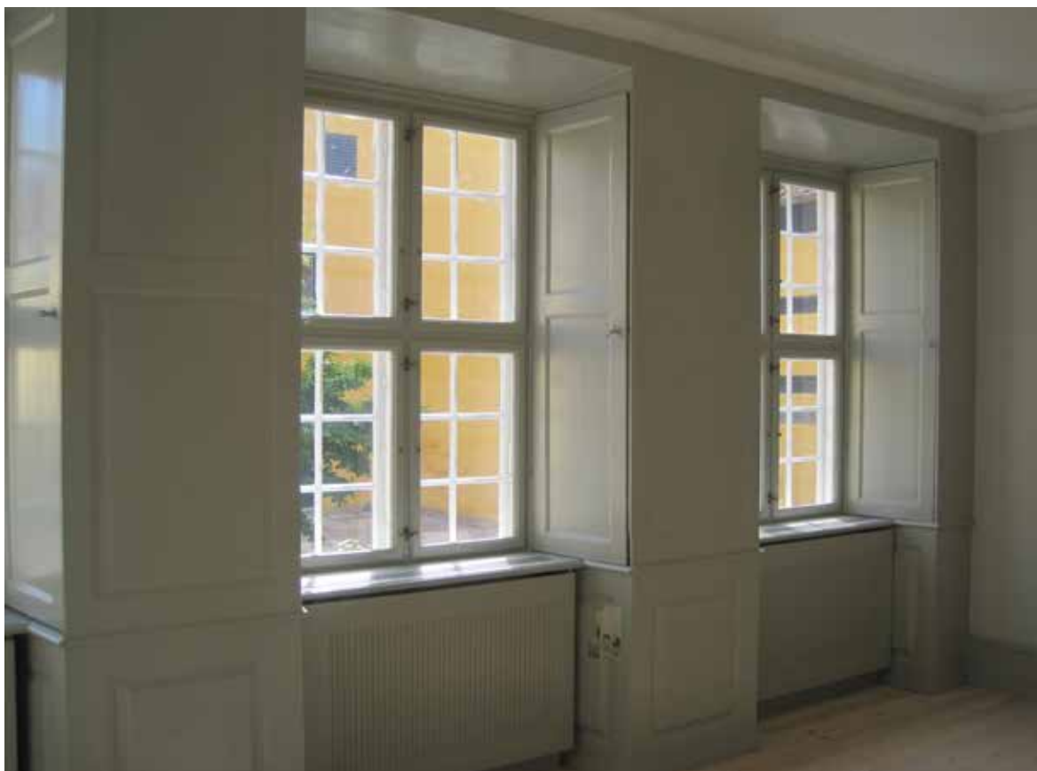
Materialforvalterboligen på Fæstningens Materialelegård, Frederiksholms Kanal i København, opført 1740. De tykke mure er indvendigt beklædt med såkaldte 'pillepaneler', d.v.s. træpaneler i vindueslysninger og på ydervægsfladerne. De er smukke og giver også ekstra isolering af ydermuren. Dette er her suppleret med indvendige forsatsruder samt isolering af brystningen under vinduet. De tykke og tunge 275 år gamle ydervægge isolerer fuldt på højde med moderne isolerede ydervægge.
