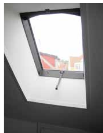
Det nye GVR-Tagvindue fra Velux er i sit design og størrelse målrettet en udnyttelse af tagrummene på ældre bygninger, hvor man ikke ønsker så dominerende ovenlys. Det har buet overside og er beklædt med enten kobber eller zink, der patinerer smukt. Til højre det gamle GVO-tagvindue set indefra.
