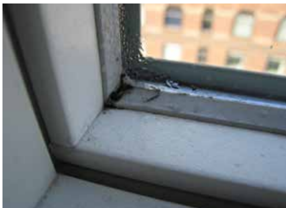
Mug og skimmel dannes ikke kun i køkkener og baderum. På visse helt nye træ-alu-vinduer er termorudekanterne så kolde, fordi aluminiummet og rudekanterne leder kulden gennem vinduet, at der under normale forhold dannes kondens her. Det varmefølsomme kamera viser at temperaturen er 6-8 grader langs disse kanter. Selv en kraftig ventilation kan ikke fjerne dette problem. Foto: Christian Oxenvad.
