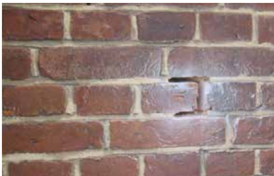
Indblæsning af hulmursisolering kan foretages stort set usynligt, og kolliderer derfor ikke med husets bevaringsværdier.
