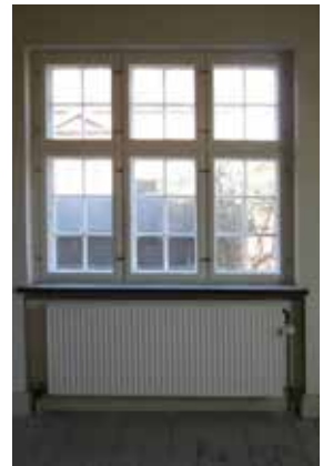
De oprindelige vinduer og de gamle rudeglas er bevarede, og bygningen er forsynet med indvendige forsatsvinduer med energiglas
