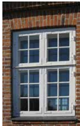
De oprindelige vinduer og de gamle rudeglas er bevarede, og bygningen er forsynet med indvendige forsatsvinduer med energiglas
