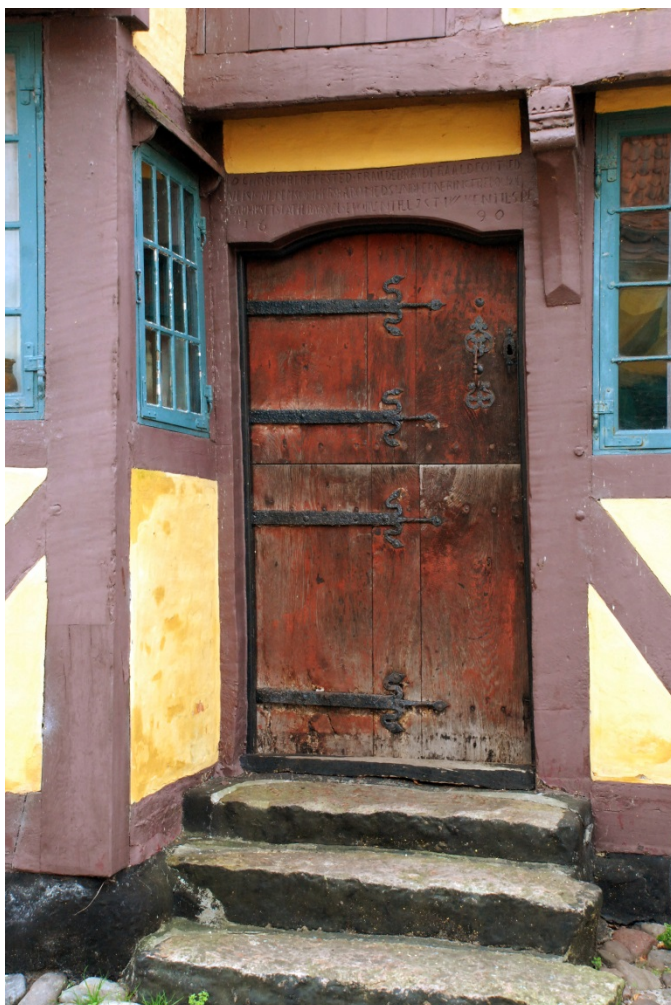
Hoveddøren til Priors Hus i Ærøskøbing er malet med en blodfarve. Det skete ved husets opførelse i 1699 – og genbehandling har ikke været nødvendig siden!
