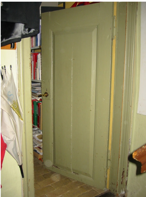
Barokdør med en stor fylding. Fyldingen er revnet i midten og døren er desuden kraftigt afkortet i underkanten, formentlig fordi gulvet på et tidspunkt er hævet.
