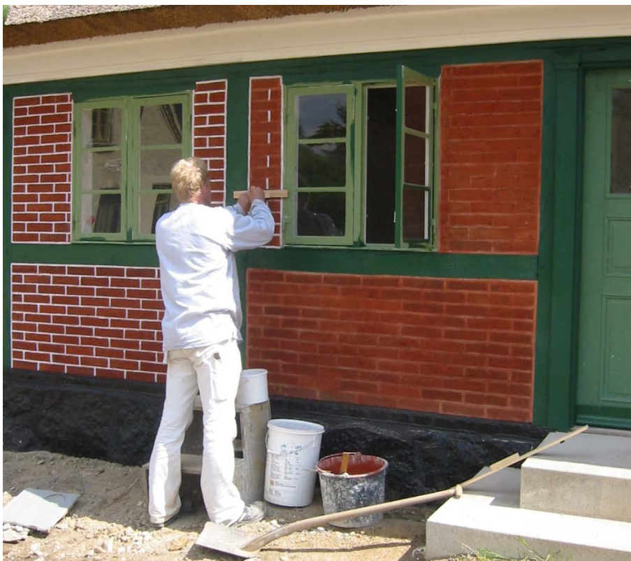
Visse steder på Fyn trækker man fugerne op med hvidtekalk, efter at muren er kalket rød med kalkfarve
