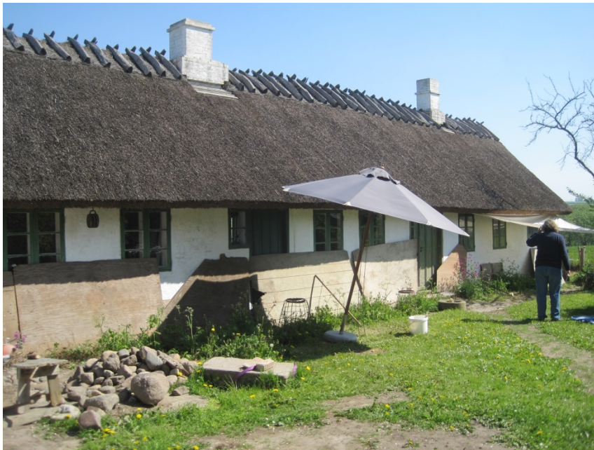
Afskærmning mod kraftig sol
