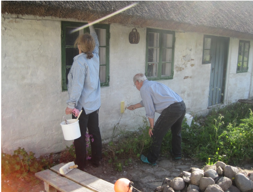
Forvanding og kalkning
