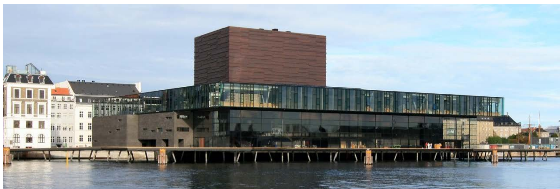
Skuespilhuset i København (Lundgård & Tranberg 2008) har to slags curtain wall mod vandet.
