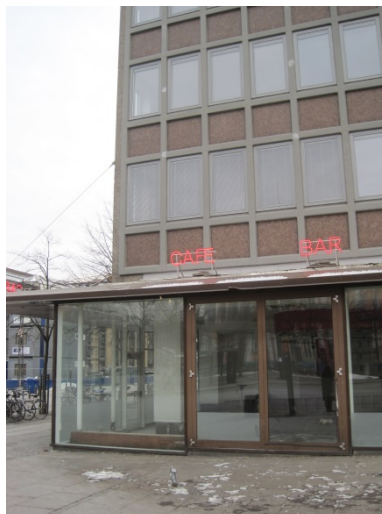
Axelborg, København Indvendige bærende søjler Stående, opdelt curtain wall Betonelementer og vinduer
