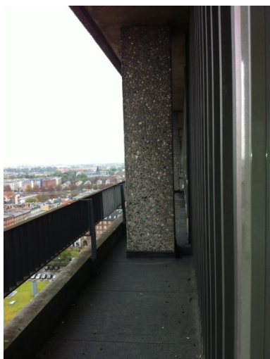
Rigshospitalet, København Udvendige bærende søjler Stående, opdelt curtain wall Termoglas i trærammer
