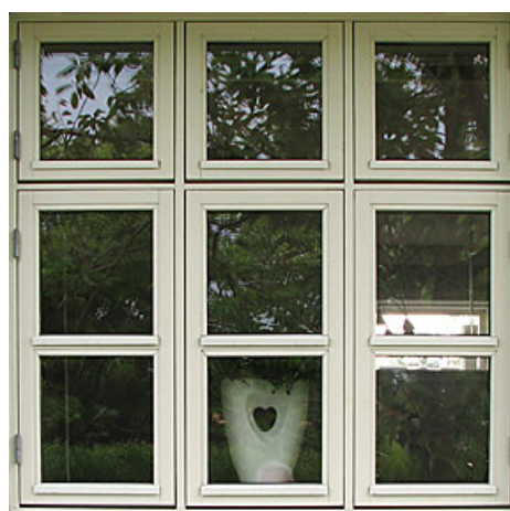
Nyt termovindue med termoruder med floatglass
