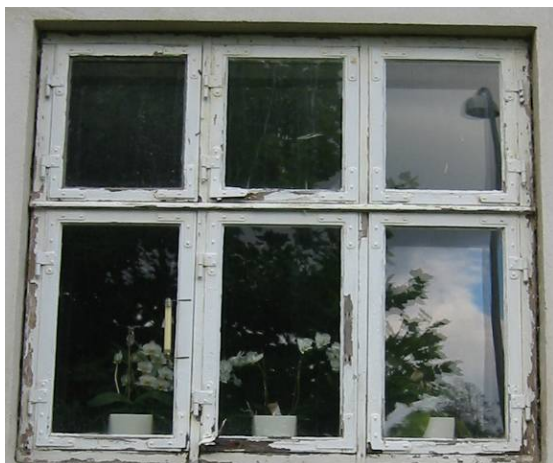
Ældre vindue forsynet med nyt floatglass
