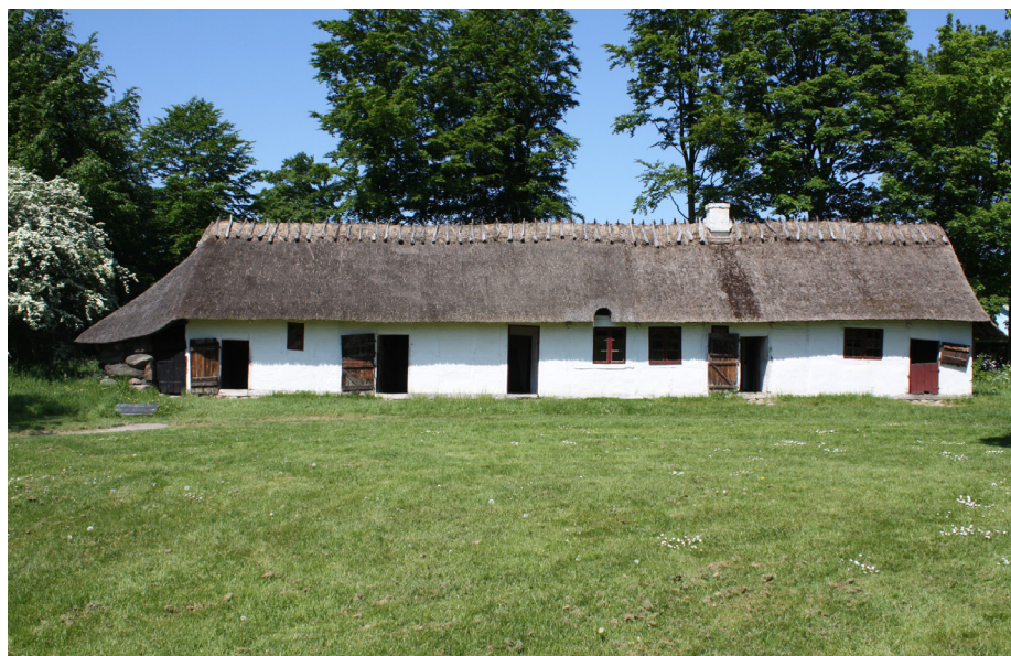
På Sjælland, på halvøen Hindsholm på Nordfyn, på Møn og som vist her på en ejendom der er flyttet til Frilandsmuseet fra Lolland-Falster, var bindingsværkshusene kalket over både tavl og tømmer. Foto: Anne Lindegaard
