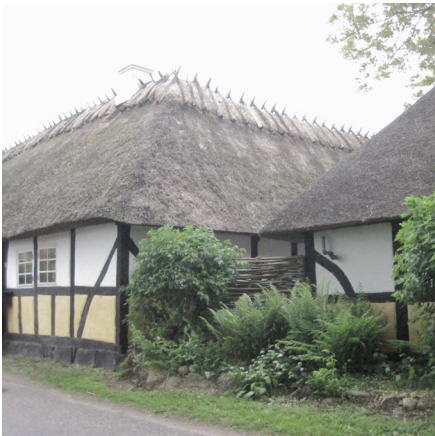
På fynske bindingsværkshuse var tømmeret opstolpet i en afvigende farve. Tavlene var ofte hvidkalkede, men visse steder også gule, røde, eller som her med gule undertavl og hvide overtavl.
