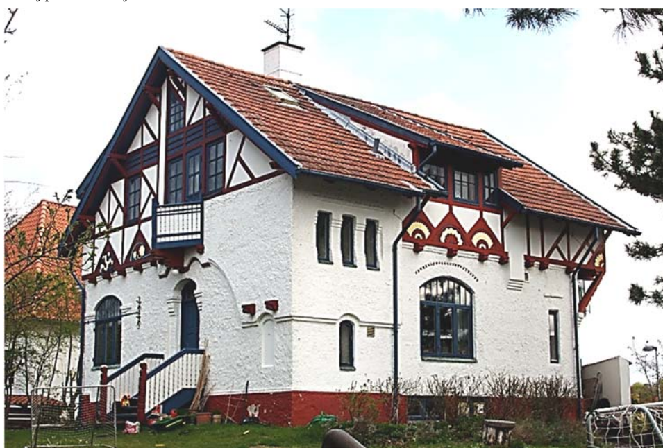
Eet af de relativt sjældne Art Nouveau (eller 'Skønvirke' på dansk) huse i Danmark. Selve stilarten er her en vigtig kulturhistorisk værdi ved huset, bl.a. fordi den er så sjælden. Rent arkitektonisk er huset knapt så velproportioneret og elegant, med pudsige vinduesplaceringer og -formater, men i den samlede bevaringsværdi, tæller kulturhistorien højere.
