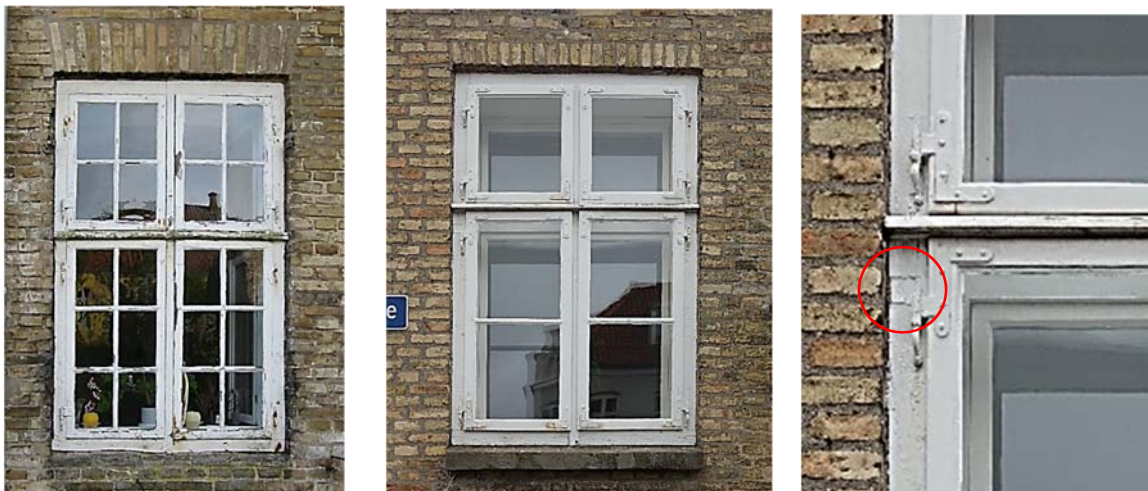
T.v. et rokoko-vindue med 20 ruder. T.h. et oprindeligt rokoko-vindue, 'ombygget' til et klassicistisk vindue med 6 ruder og overfalsede rammer (hvorved de ligger 'uden på' karmens forside). Dette kræver at tværposten hæves 5-6 cm for at proportionerne kan gå op. Dette er ikke noget problem for en god snedker. Begge typer vinduer ses flere steder i samme bygning, lige ved siden af hinanden (se side 33), som om man ikke har haft tid endnu til at ændre alle vinduerne efter den nyeste mode i begyndelsen af 1800-tallet.
