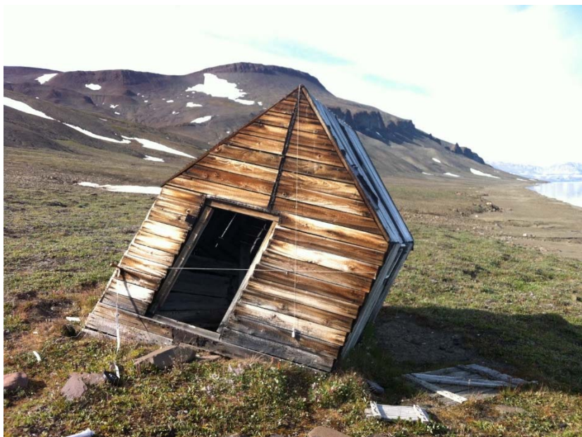
Det 'skæve' hus i Nordøstgrønland igen, igen. Men det illustrerer ret godt, hvad man skal med en vagesnor og en vagelinje samt en lodsno og en lodlinje, når man måler skæve og andre huse op.
