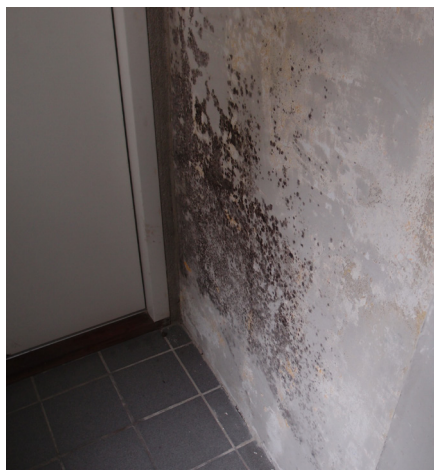
Skimmel på kold og fugtig kældervæg.
