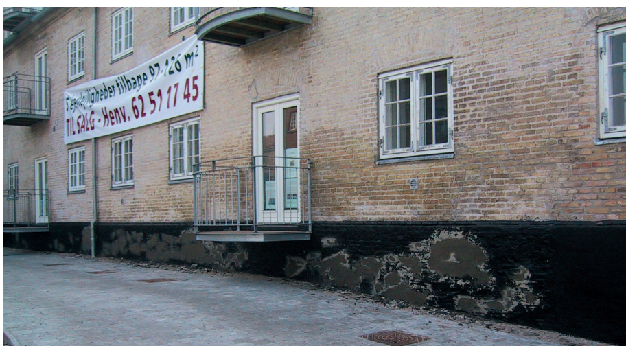
Hvis man spærret fugten inde i en muret sokkel, f.eks. med KC-mørtel og sokkelasfalt, trænger fugten bare højere op i murværket – her næsten op over vinduerne.
