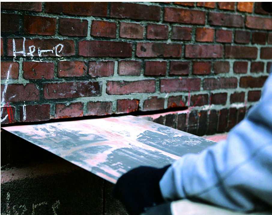
Indskydning af fugtstandsende plader i en udsavet fuge. Denne løsning må ikke benyttes på fredede huse. Foto: Holger Schultz
