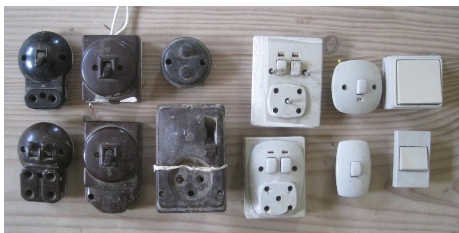
Øverst: Danske el-kontakter fra ca. 1900 – 1930 i messing eller brun, sort eller hvid bakelit på en hvid eller sort porcelænsfatning. Efter et sikkerhedscheck kan disse evt. stadig anvendes. Nederst: Danske el-kontakter fra 1930 – 1980 i brun eller sort bakelit – efter 1950 i grå plastik. Den lille runde funkis-afbryder afbringes på selve gerichten/dørindfatningen, der samtidigt blev udført plan, uden profileringer.
