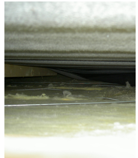
Efterisolering af et tagrum mellem spærene. Der opsættes en diffusionsåbent, selvbærende undertag oven på spærene med lægter og tagsten over. Herunder isoleres der med mineraluld, men andre isoleringsmaterialer i batts kan også bruges, f.eks. hør, cellulosefibre, papir. Det er vigtigt, at der etableres et fastholdt, ventileret hulrum på 3-5 cm (billedet t.h.) mellem isolering og undertag. Her sidder der ståltråde, der forhindrer isoleringen i at lukke hulrummet.
