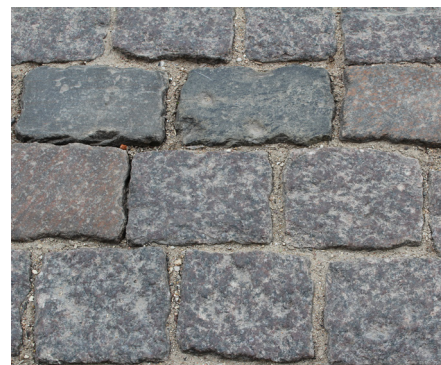
Stenene tages op og bruges igen, når de underliggende grusbærelag er udskiftet og rettet op. Foto: Anne Lindegaard
