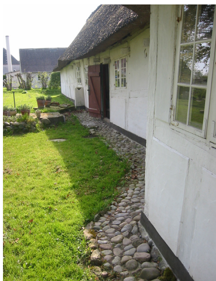
Ved huse uden tagrender anlagdes et ca. 1 m bredt pikstensbånd langs facaderne for at tage imod tagdryppet og modvirke jordsprøjt og fugtighed på væggene.
