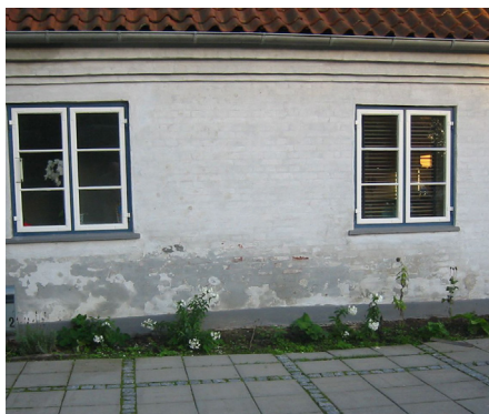
Typisk eksempel på opadstigende fugt, der ikke kan komme ud i sokkelniveau pga. en for hård og tæt sokkelpuds – fugten stiger derfor højere op i murværket.
