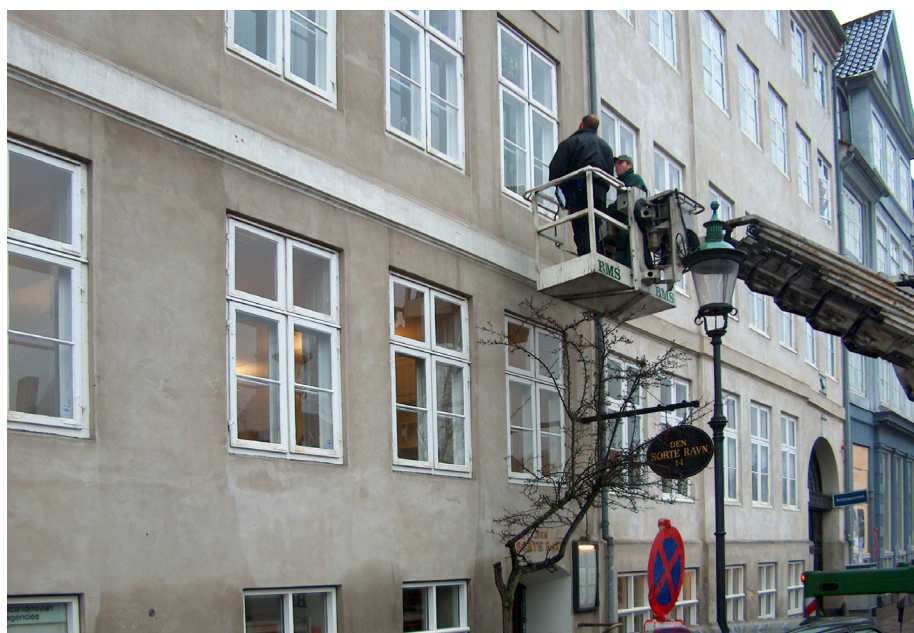
En omhyggelig teknisk undersøgelse er en vigtig del af et restaureringsprojekt for et ældre hus.
