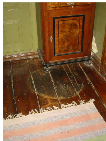
Spor i gulvet efter en tidligere kakkelovnsplacering
