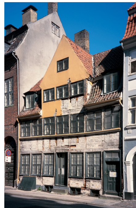
I byerne stod bindingsværkshusene ofte overpudsede, og i mange tilfælde huggede man små fordybninger i stolperne for at få puds til at hænge ved, eller man sømmede træpinde eller rørvæv på tømmeret.
