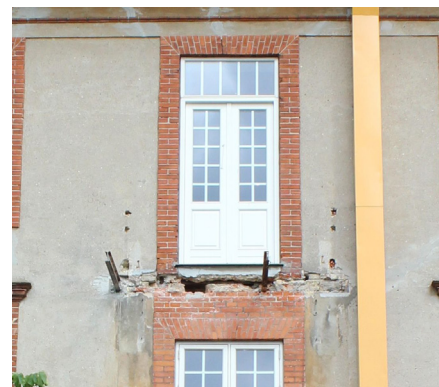
I karnapper og altaner vil det normalt være jernbjælker, der bærer vinkelret på facaden, og betonen der bærer parallelt med facaden. Betonen skal beskytte jernbjælkerne og skal derfor være tæt. Her er altanen fjernet, så I-jernene, der normalt bærer altandækket, fremstår synlige. Foto: Anne Lindegaard
