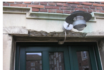
I karnapper og altaner vil det normalt være jernbjælker, der bærer vinkelret på facaden, og betonen der bærer parallelt med facaden. Betonen skal beskytte jernbjælkerne og skal derfor være tæt. Her er altanen fjernet, så I-jernene, der normalt bærer altandækket, fremstår synlige.
