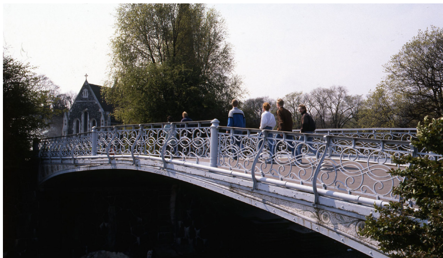
Den meget elegante jernbetonbro, der fra Gefion Springvandet fører hen over den tidligere vejforbindelse til Københavns Frihavn, blev udført i 1894 efter tegninger af professor A. Ostfeld. Broen består af et jernbetondæk, dvs. et betondæk med indstøbte, tynde jernstænger.
