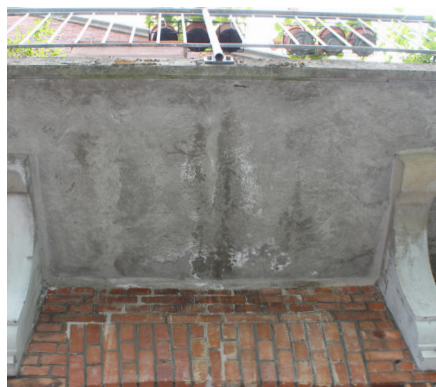
Indstøbte I-jern i altandæk, der hviler på betonkonsoller. Der er i dette tilfælde sivet vand igennem betondækket og ned til jernbjælken, der tydeligt ses lige i midten, med rustsprængning til følge. Skaden udbedres med rustbeskyttelse – typen afhænger af, hvor tykt et lag reparationsmørtel, der skal tilføres. Hvis det er under 20 mm tykt kan der evt. benyttes ikke-opløsning epoxy til rustbeskyttelse. Foto: Anne Lindegaard
