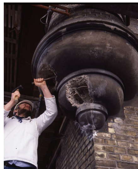
Prøveophugning i en betonkonstruktion, hvor man hugger ind til de bærende jern, der forventes at være inde i betonen. Her kan man konstatere rust eller tæring og konstatere betonens tæthed.
