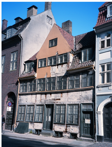
Mange bindingsværkshuse er med tiden blevet overpudsede eller plasticmalede. Begge dele medfører, at bindingsværket ofte rådner under den meget tætte overflade. Dette kan bl.a. ses ved at plastikmalingen bugler og revner mange steder.
