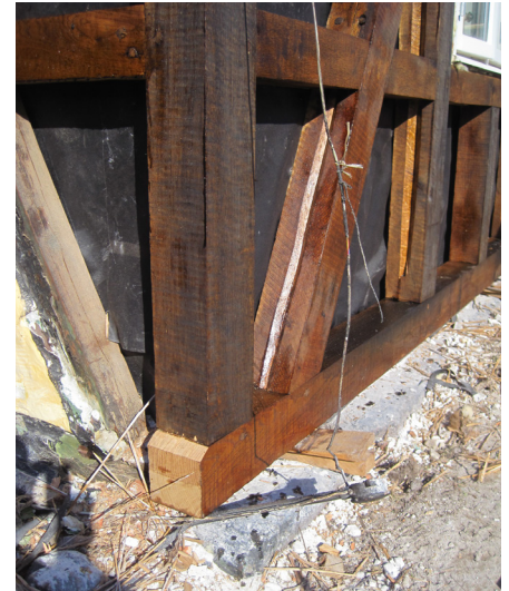
Hvis man skal skifte en hel stolpe – eller blot en stolpeende – kan man ikke få ægte tapper i fodrem og tagrem, men må i stedet udføre en løs tap, der dyvles fast som her.
