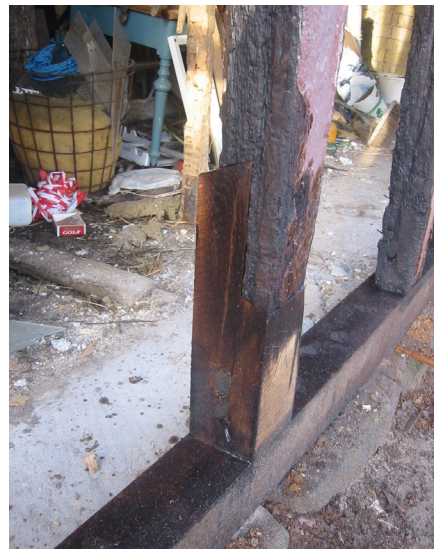
To kraftige trædyvler på skrå ned i samlingen virker lige så godt og stærkt som en normal tapsamling.
