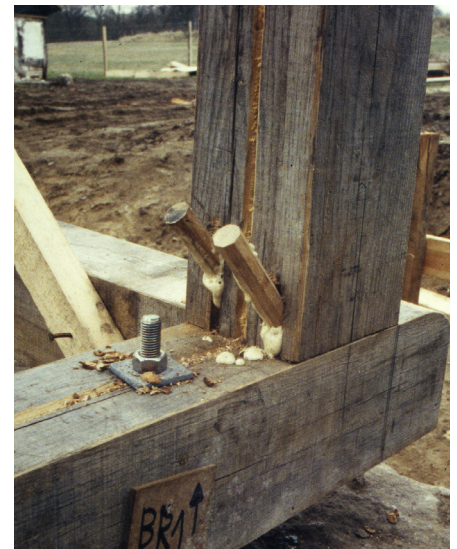
Hvis man skal skifte en hel stolpe – eller blot en stolpeende – kan man ikke få ægte tapper i fodrem og tagrem, men må i stedet udføre en løs tap, der dyvles fast som her.
