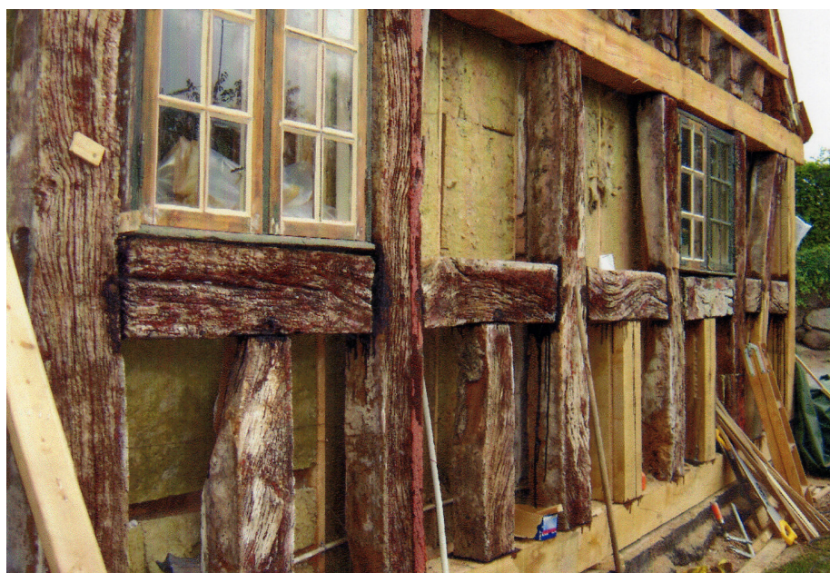
Bindingsværkshus med rester af rødokker (kaseinfarve).
