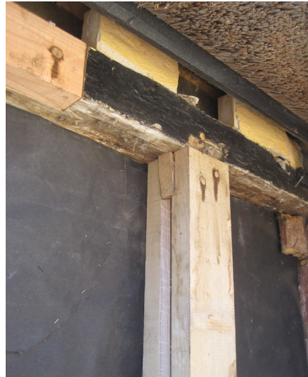
Hvis man skal skifte en hel stolpe – eller blot en stolpeende – kan man ikke få ægte tapper i fodrem og tagrem, men må i stedet udføre en løs tap, der dyvles fast som her.
