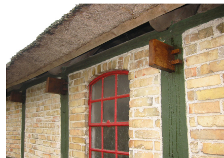
Hvis de gennemstukne bindbjælker mangler eller har rådne eller flækkede tappe, skal disse skiftes, f.eks. med en løs gennemstukket tap som her. Ellers kan husets tværstivhed være svækket.
