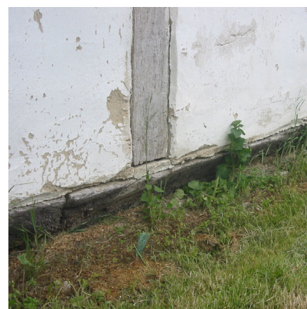
Fodremmen er det mest udsatte på et bindingsværkshus, især som her, hvor den er halvt begravet i terrænet. Så rådner den hurtigt, men det er heldigvis forholdsvis enkelt at skifte den ud.
