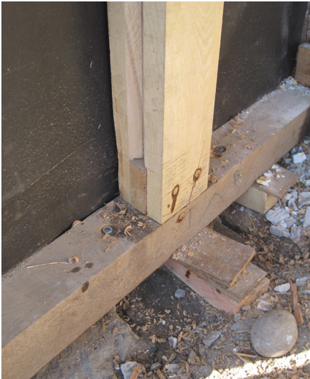
Hvis man skal skifte en hel stolpe – eller blot en stolpeende – kan man ikke få ægte tapper i fodrem og tagrem, men må i stedet udføre en løs tap, der dyvles fast som her.
