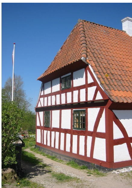
Repareret bindingsværkshus overfladebehandlet med rødokker limfarve (kaseinfarve) på tømmeret og hvidtekalk på de pudsede (luftkalkmørtel) tavl.
