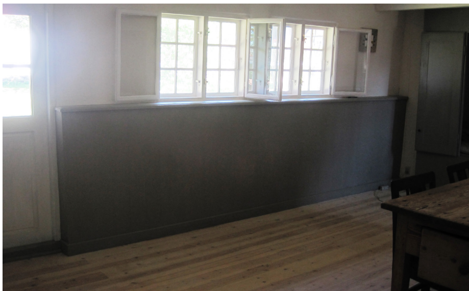
Her ses den lille 'forsatsisolering' under vindueshøjden i rummet. Den kan udføres som et malet brystningspanel og klæder ligefrem rummet. Over vinduerne er væggene fortsat uisolerede og 'tynde', hvilket gør rummet smukkere og ikke så 'smalt' som hvis isoleringen var ført til loftet. Overvæggene er her pudset med kalkmørtel og limfarvet.
