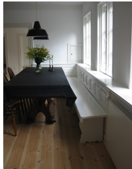
Den indvendige, efterisolerede panelvæg under vinduerne kan eventuelt - som lidt specielt her - udføres som ryglæn i en langbænk langs vinduerne.
