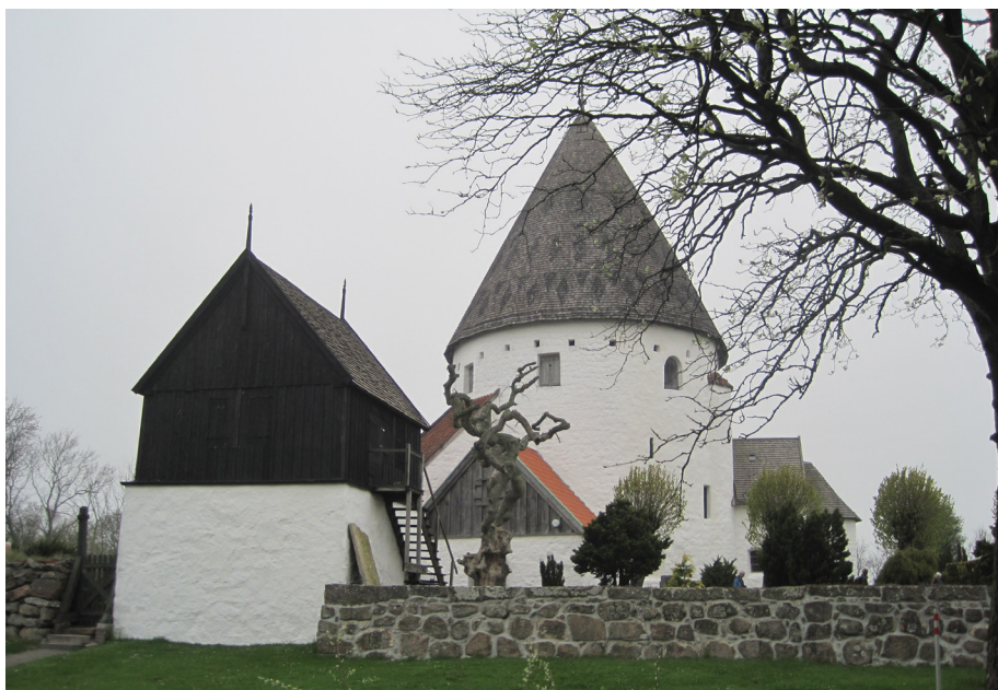
De bornholmske rundkirker og deres klokkehuse hører til de mest markante spåntækkede bygninger i Danmark. Lagt med spejlkløvede egespån, der vedligeholdes med trætjærefarve, holder disse tage i over 200 år. Foto: Anne Lindegaard
