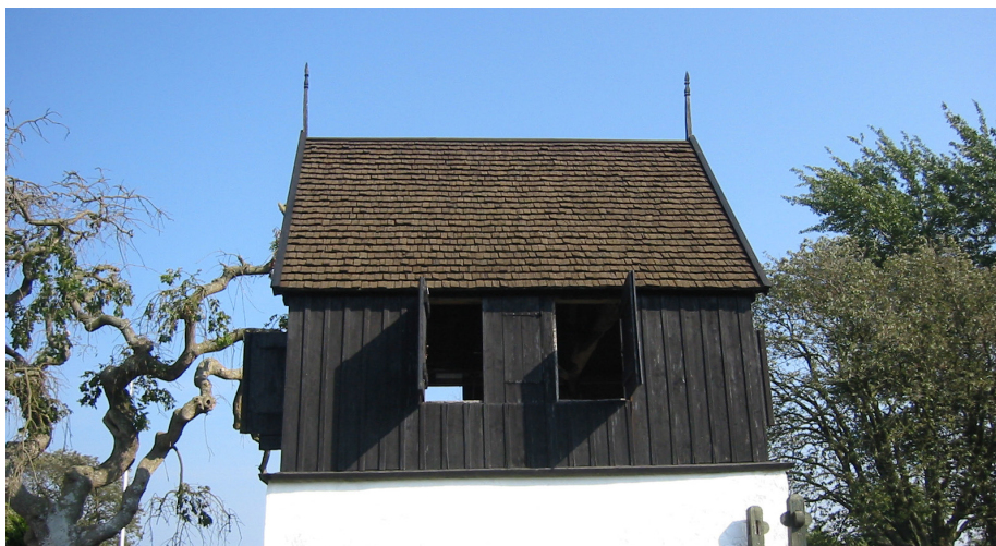
Der er som nævnt stor forskel, rent teknisk og holdbarhedsmæssigt, og naturligvis også prismæssigt, på spejlklovede spån og savede spån. Men arkitektonisk og æstetisk er det en oplevelse at betragte et spåntag – hver gang, man har chancen for det. Foto: Anne Lindegaard
