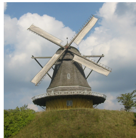
Træspån egner sig perfekt til tækning af krumme, runde, kantede, gratede eller helt lodrette flader. Derfor er mange møller – eller blot møllehatte – spåntækket. Her Viby Mølle på Hindsholm
