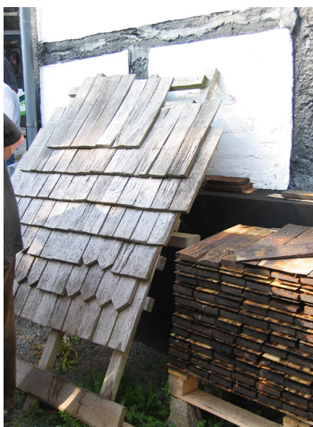
Proveoplægning af de spejlklovede egespån. På grund af den lange kileform ligger spånene i 3 lag oven på hinanden, forskudt en halv spån og med indbyrdes overlæg. De tre lag fremkommer ved, at hver spån dækker 2/3 ned over den foregående. Underlaget er brædder eller lægter.
