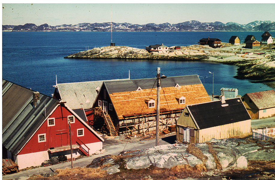
Spånene oplægges i vandrette skifter (baner) begyndende ved tagfoden. De oplægges med en indbyrdes afstand på 3-5 mm for at sikre udluftning og give plads til udvidelse i fugtigt vejr. Ved tagfoden etableres trelagsdækning. Det første skifte dækkes helt af det andet skifte. De følgende spånskifter oplægges efter retholt (lige bræt), således at kun 1/3 af det foregående skifte er synligt. Retholtet flyttes med op for hvert skifte. Eventuelt kan retholtet forsynes med pasmærker, således at lægningsmønstret bliver ensartet.
