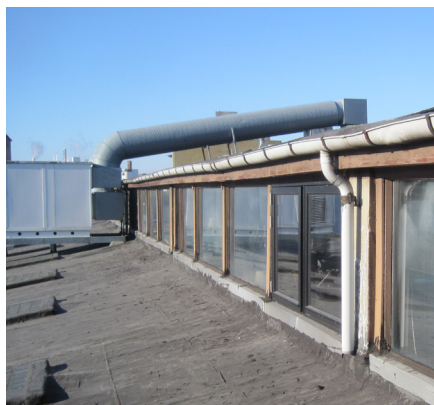
Jernbetonhal fra 1929 på Amager med det originale paptag, før rullepappen, helt intakt – skønt lappet og tjæret utallige gange. Stenkulstjæren får et meget smukt, hvidligt skær, formentlig af solens nedbrydning, men kun det firma, der bor oppe under taget kan se det.
