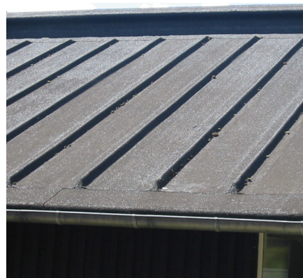
Et listedækket paptag får, gennem de skygger listerne kaster på taget, lige pludselig en struktur i taget, der smitter af på bygningen. Taget og bygningen får på denne måde tydeligvis mere status og et arkitektonisk løft.
