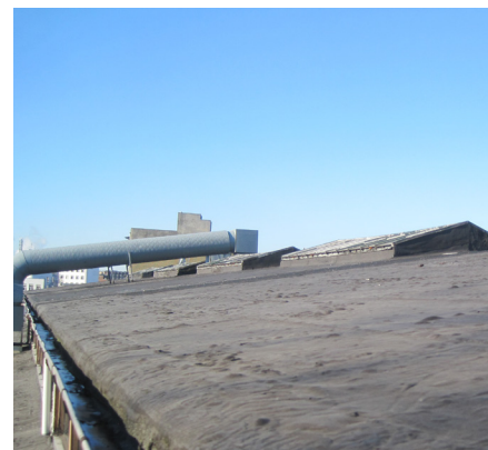
Jernbetonhal fra 1929 på Amager med det originale paptag, før rullepappen, helt intakt – skønt lappet og tjæret utallige gange. Stenkulstjæren får et meget smukt, hvidligt skær, formentlig af solens nedbrydning, men kun det firma, der bor oppe under taget kan se det.
