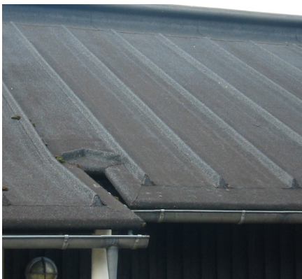
Et listedækket paptag får, gennem de skygger listerne kaster på taget, lige pludselig en struktur i taget, der smitter af på bygningen. Taget og bygningen får på denne måde tydeligvis mere status og et arkitektonisk løft.
