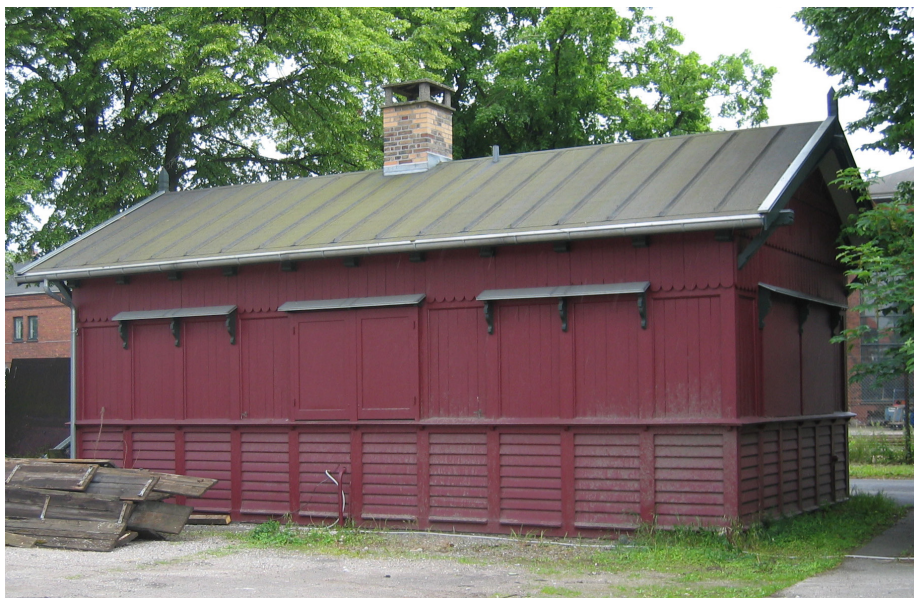
Et smukt eksempel på konstruktiv træbeskyttelse af en træbygning. Et godt paptag med lister, et kraftigt udhæng, vandbrædder over vinduer og underfacaden og selve underfacaden beklædt med klinklagte brædder, som vandet løber godt af.
