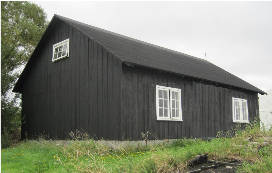
Enkelt og lavmælt 'bødeskur' af brædder en på to og et helt glat paptag. Alt er sorttjæret, bort set fra de lysende hvide vinduer. Huset er placeret på en kystskrænt direkte ud til havet og skal derfor passe ind i både omgivelserne og sin funktion som oplagsskur for fiskerne, hvor de samtidigt kan bøde deres fiskegarn (binde knækkede snore sammen). Den enkle form og de meget enkle materialer klarer dette.
