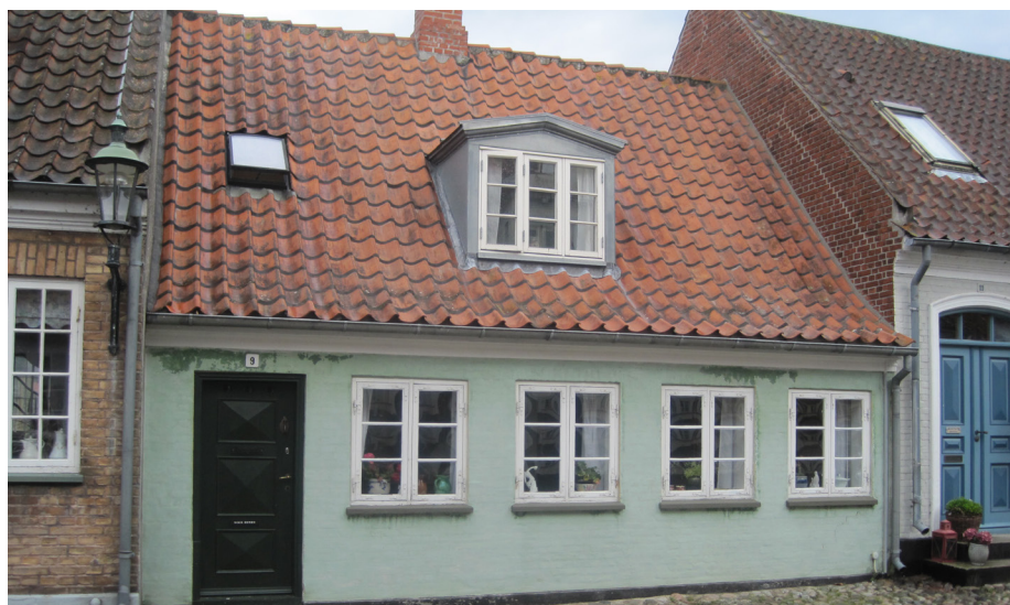
Fin, enkel og klassisk midteranbragt kvist. Det er rigtigt at udvide den til tre vinduesfag, selv om det har kostet et oversavet spær, men denne kvist er faktisk bedre i proportionerne i forhold til en enkelt 2-fags kvist eller to 2-fags kviste.
