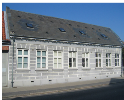
I dette mørke skifertag passer de meget mørke GVO-tagvinduer udmærket. I et tegltag bliver de straks mere synlige, men det kan trods alt være en pænere mulighed for at få dagslys i et tagrum, hvis dette er nødvendigt, end både kviste og store ovenlys hvis det drejer sig om et bevaringsværdigt hus. På fredede bygninger tillades GVO-tagvinduer ikke.
