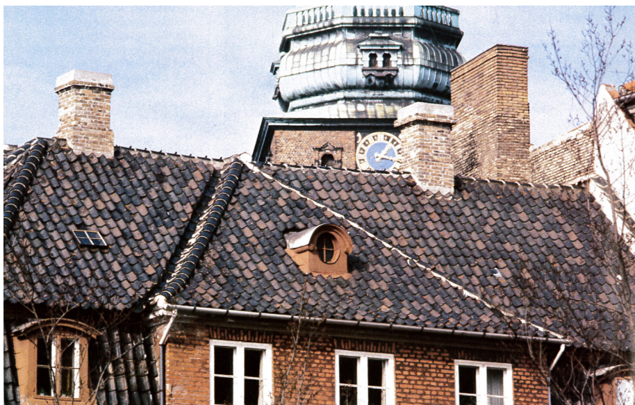
Rygninger og grater på tegltage skal lægges i mørtel, og skorstenspiber bør også indmures med mørtel som her, og ikke inddækkes med zink eller lignende.
