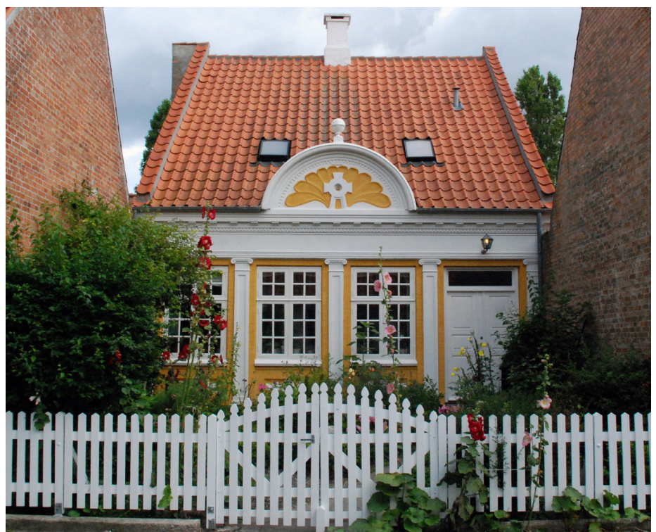
Smukt opskalket og inddækket tegltag, som der heldigvis er mange af overalt på ældre danske bygninger – her i Årskøbing.
