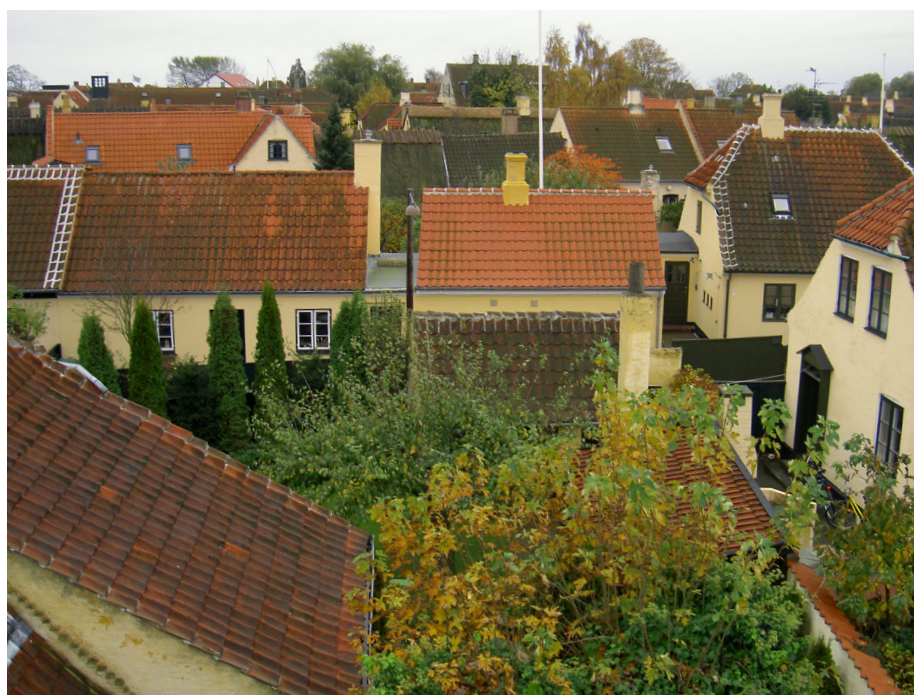
Udsigt over dansk provinsby med tegltage, skorstene med indmurede inddækninger og enkelte steder hvidkalkede forskellinger langs gavlene og tagryggen.
