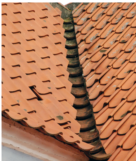
Hvis taget er forsynet med et fast undertag af brædder og pap kan man med fordel udføre skotrenderne med tegl i bunden. Det harmonerer smukt med taget i øvrigt og repræsenterer en gammel tradition.
