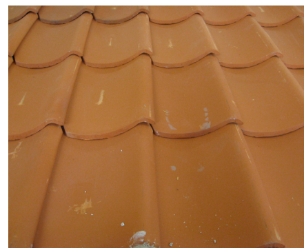
Ved understrygning og forskelling skal der ikke bruges mere mørtel end nødvendigt for tætning og ved- hæftning - det giver det pæneste udseende. Man skal også passe på, at understrygningsmørtel ikke bliver synlig udefra, fordi den derved kommer så tæt på teglstenenes løb, at den kan opsuge vand, der kan føre til frostsprængninger.
