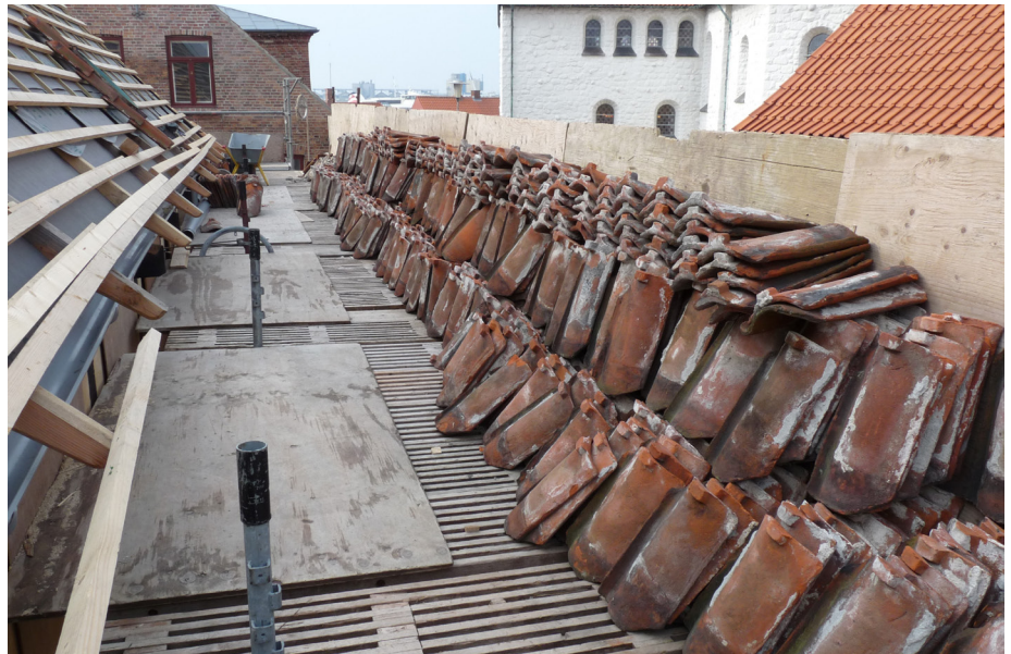
Tag lægges med genbrugssten. De gamle tagsten kontrolleres for fejl og revner, de dårlige kasseres og de gode lægges forsigtigt i stabler på stilladset.
