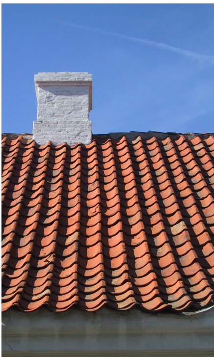
Tag lægges med genbrugssten. De gamle tagsten kontrolleres for fejl og revner, de dårlige kasseres og de gode lægges forsigtigt i stabler på stilladset.
