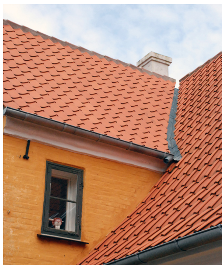
Hvis taget er forsynet med et fast undertag af brædder og pap kan man med fordel udføre skotrenderne med tegl i bunden. Det harmonerer smukt med taget i øvrigt og repræsenterer en gammel tradition.
