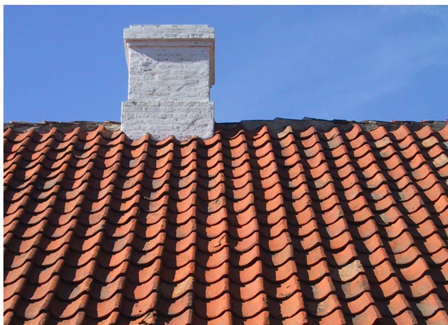
Den traditionelle måde at inddække (tætte) skorstene i tegltage på er ved at udføre en indmuret inddækning. Den er diskret, naturlig, billig og holder tæt og godt – modsat en moderne zinkinddækning samme sted, der er materialemæssigt meget synlig og dominerende, dyr og beroende på zinkens holdbarhed i et udsat klima.
