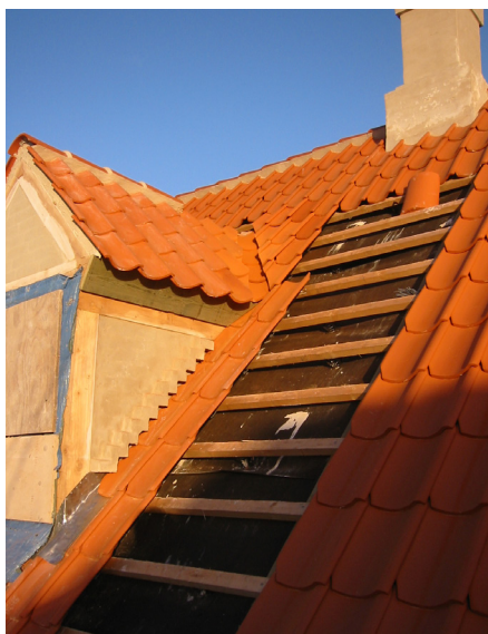
De enkelte skotrendesten fastholdes i siderne med varmgalvaniserede søm, der sømnes til vandkanterne. Samlingerne mellem stenene forskelles (lukkes) med hydraulisk kalkmørtel. Mørtlen skal beskæres, så tagstenene står med rene og fritskårne kanter. Desuden skal undertaget føres med ud i skotrenden.
