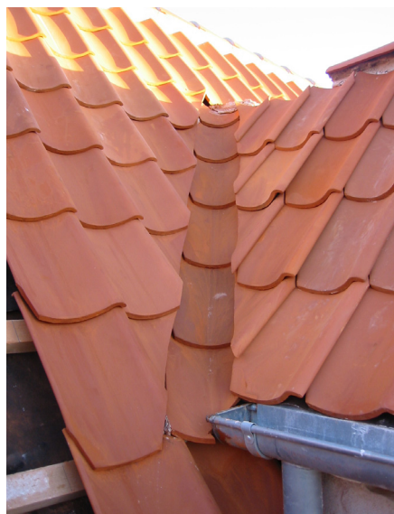
De enkelte skotrendesten fastholdes i siderne med varmgalvaniserede søm, der sømnes til vandkanterne. Samlingerne mellem stenene forskelles (lukkes) med hydraulisk kalkmørtel. Mørtlen skal beskæres, så tagstenene står med rene og fritskårne kanter. Desuden skal undertaget føres med ud i skotrenden.
