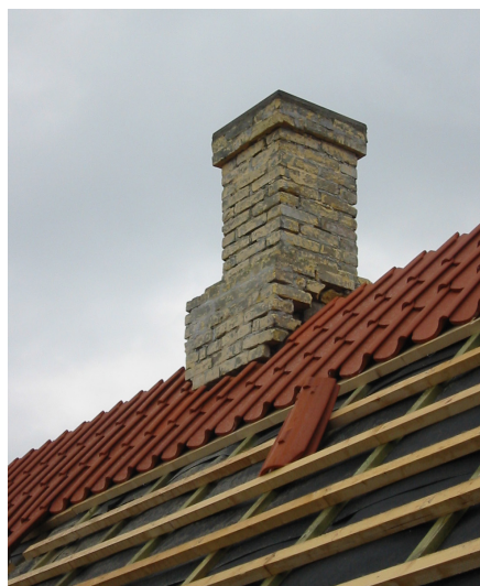
Her ses hvordan den indmurede inddækning i en skorsten udføres ved at der opbygges en reces (indhak) i skorstens sokkel, i hvilken tagstene kan føres et par centimeter ind, hvorefter indmuringen lukkes med en hydraulisk kalkmørtel.
