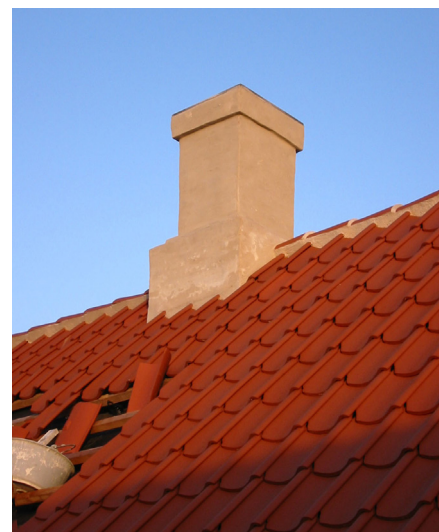
Her ses hvordan den indmurede inddækning i en skorsten udføres ved at der opbygges en reces (indhak) i skorstens sokkel, i hvilken tagstene kan føres et par centimeter ind, hvorefter indmuringen lukkes med en hydraulisk kalkmørtel.
