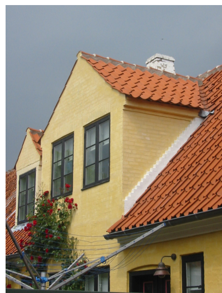
I Dragør er der gammel tradition for at udføre skotrender med teglsten i bunden og murede inddækninger på siden af kviste og brandkamme samt murede inddækninger af skorstene. Herved undgås zinken helt, og de indmurede kvistflunker kan understreges med hvidtekalk som her.
