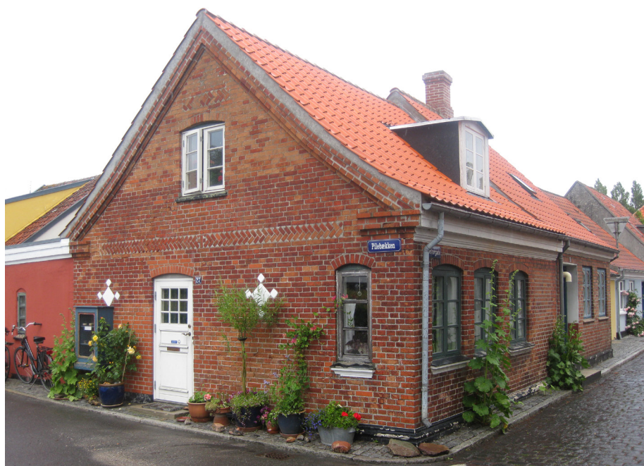
Ved oplægning af nyt tegltag med undertag 'løfter' man taget 2-5 cm. I forhold til det oprindelige udseende. Dette kan godt udføres, så tagfoden og tagrendehøjden ikke løftes, men ved gavlene vil tagets nye højde ses. En pudset gavl kan skjule dette, men ved gavle med synlige mursten kan man lægge en mursten yderligere på gesimsbåndet, eller fylde op med mørtel som her.
