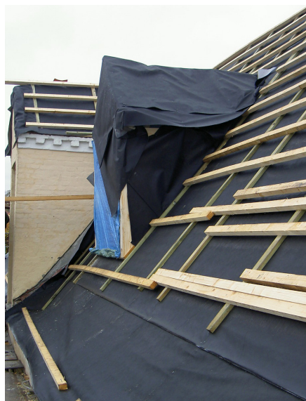
Ved genoplægning af genbrugstegl er etablering af et undertag en ekstra sikkerhed for at taget holder tæt.
