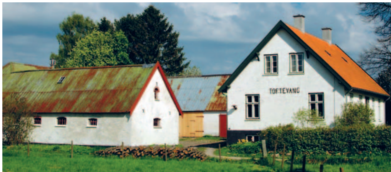
Gården 'Toftevang' i Veksebo er et typisk eksempel på en nybygget gård fra slutningen af 1800-tallet med de for sin tid typiske byggemåder og materialer, bl.a. grundmur, på stuehuset med tegltag og på udlængerne moderne bliktag, der mange steder afløste stråtagene.
