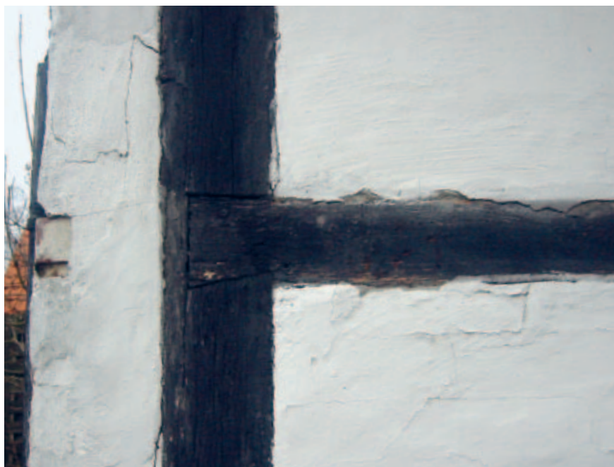
Sørup. Den særlige 'sjællandske' bindingsværkskonstruktion med udvendige vandrette 'sidebånd' rummer en meget speciel detalje, nemlig en 'kæmme svalehale' eller en 'svalehale-kæmning'. Denne ses her både 'in natura' og i tegning. Se i øvrigt side 42.
