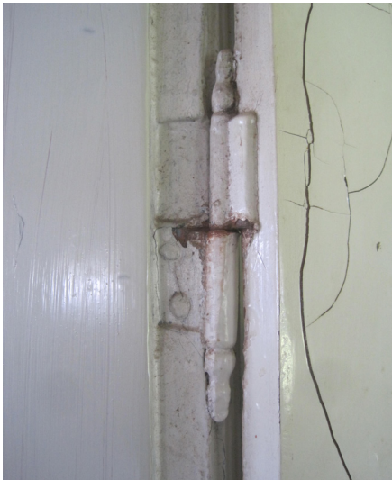
Indstukket dørhængsel også kaldt et hollandsk hængsel. Der stikkes en smal rille i hhv. dørbladet og i karmen med et særligt stemmejern, en såkaldt hængselbeitel eller lyrebeitel. Hængslets dele bankes i og sikres med to eller tre stifter. Yderst til højre en nysmedet kopi af et hollandsk hængsel.
