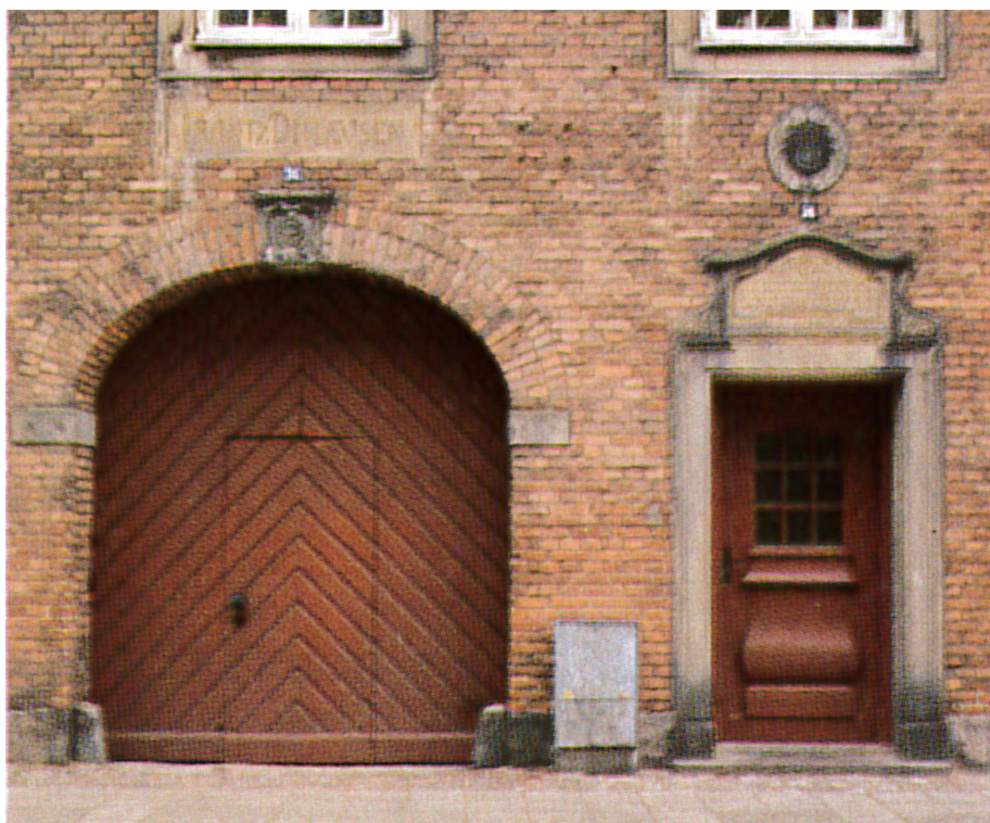
Udvendige døre og porte er meget udsatte for vejr og vind, plus at de, for dørenes vedkommende, i lange perioder er udsat for ret store temperaturforskelle på hver side. Derfor er der for det første udvist meget stor omhu ved dørens konstruktion, materialevalg og udførelse. Dernæst vil man se, at mange yderdøre er søgt beskyttet af et lille tag, kaldet en fordakning, eller at døren og porten ligger så dybt som muligt inde i murfalsen. Foto: Anne Lindegaard
