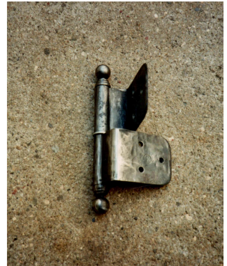
Indstukket dørhængsel også kaldt et hollandsk hængsel. Der stikkes en smal rille i hhv. dørbladet og i karmen med et særligt stemmejern, en såkaldt hængselbeitel eller lyrebeitel. Hængslets dele bankes i og sikres med to eller tre stifter. Yderst til højre en nysmedet kopi af et hollandsk hængsel.
