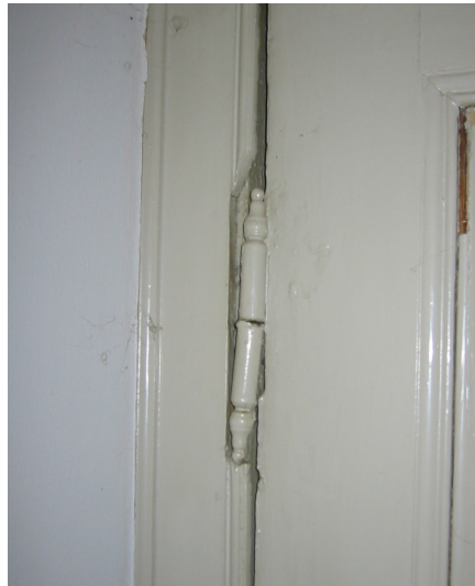
Indstukket dørhængsel også kaldt et hollandsk hængsel. Der stikkes en smal rille i hhv. dørbladet og i karmen med et særligt stemmejern, en såkaldt hængselbeitel eller lyrebeitel. Hængslets dele bankes i og sikres med to eller tre stifter. Yderst til højre en nysmedet kopi af et hollandsk hængsel.
