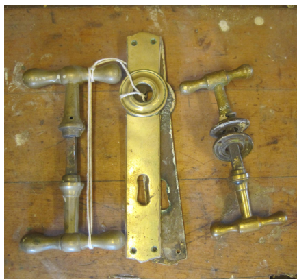
Typiske T-greb af messing fra 1700- og 1800-tallet. De kunne fremstilles i forskellige størrelser, tilpasset selve dørens størrelse.
