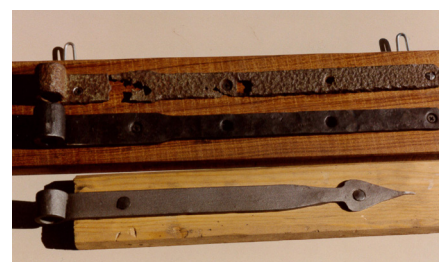
Forskellige båndhængsler til porte. Øverst det gamle forvitrede beslag, og under dette nysmedede kopier.
