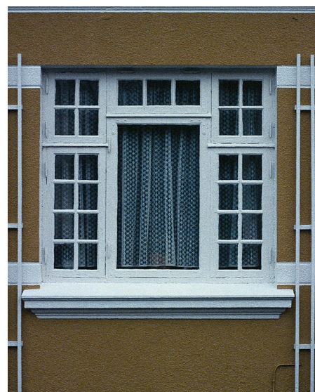
Typisk Bedre Byggeskik-vindue. Til trods for opfindelsen af det trukne glas i 1915, hvor man kunne producere meget større ruder end før, går man 'tilbage' til meget små ruderformater – kombineret med store ruder som her. Under Bedre Byggeskik vinder den hvide vinduesfarve frem. Før den tid var vinduerne i Danmark brune, grønne, røde, grå og gule udvendigt.
