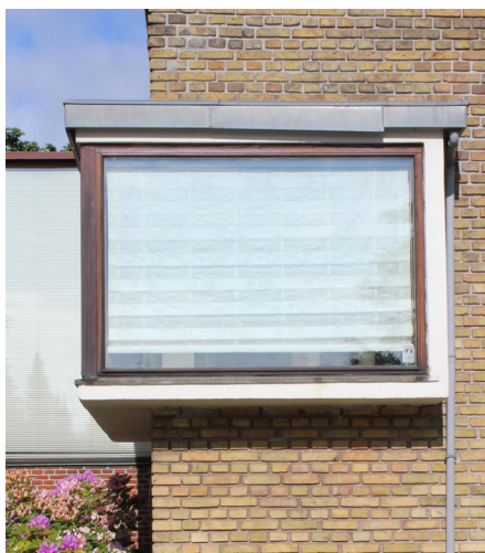
Funktionalistisk vindue fra 1950'erne. Sprosserne går af mode, men rammen udføres så spinkel som mulig. Her har vinduet yderligere en fin indfatning af beton. Foto: Anne Lindegaard
