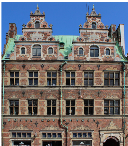
Renæssancens vinduer består for det meste af blysprossede ruder i trærammer, sat direkte i vinduets sandstensindfatning. Foto: Anne Lindegaard
