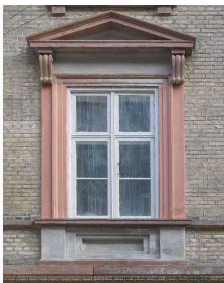
Typisk klassicistisk vindue set udefra. Tværposten sidder i tredjedelspunktet og deler sammen med lodpost og rammer vinduet i seks lige store ruder. De underste rammer har to ruder delt af én vandret sprosse. Hjørnebåndsbeslagene er forenklet og symmetriske. Vinduesindfatninger af natursten er med til at fremhæve vinduernes betydning i facaden, f.eks. i endefagene. Farven har oprindeligt ikke været hvid, men grå, mørkebrun eller mørkegrøn.
