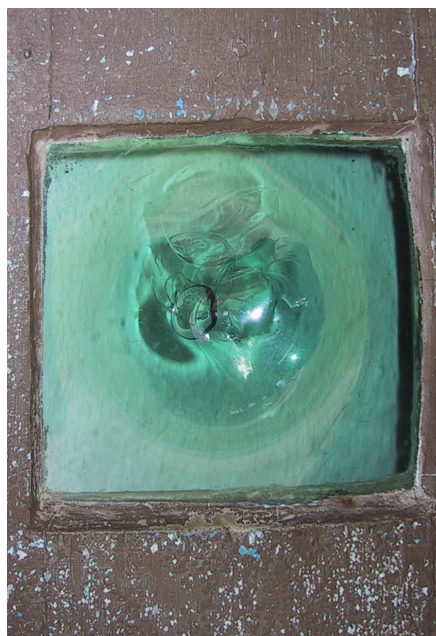
Centerdelen af kronglasskiven, som var tykkest og mindst gennemsigtig var egentlig et affaldsprodukt. Dette blev ofte brugt, hvor gennemsigtigheden var mindre afgørende, f.eks. som yderdøres småruder, og kendes under betegnelsen "galle" eller "okseøjel".
