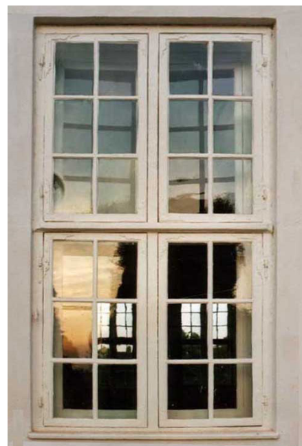
Typisk barokvindue set udefra med midterdelt tværpost, 4 gange 6-rude rammer med træsprosser og dekorerede hjørnebåndbeslag. Farven har oprindeligt ikke været hvid, men grå, rød, brun, mørkegrøn eller rød.
