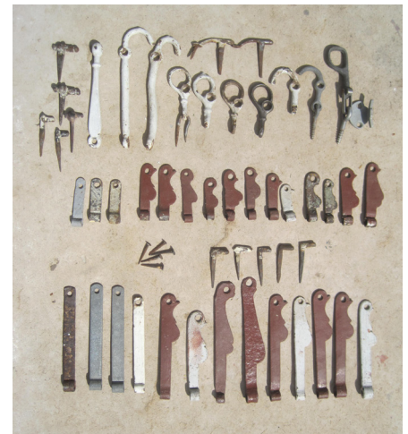
Indvendige vinduesbeslag: Fra venstre; Hasper og stormkroge fra 1850-1950. I midten nederste: tre hasper fra 1800-tallet. I midten øverst fugleanverfere fra 1700-tallet og til højre: stormkroge fra 1700-tallet og (nederst) 1800-tallet.
