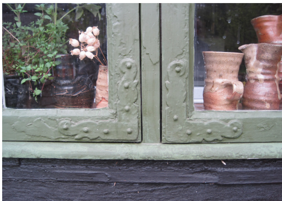
Originale og smukt og enkelt dekorerede vinduesbeslag fra 1750'erne (Ærøskøbing). Det korrekte er at sømme vinduesbeslagene på med rundhovedede søm som her – deraf navnet 'beslag' = beslå, sømme på. Det korrekte er også, som det ses til højre, ikke at sømme i selve hjørnet af vinduesrammen, hvor der både er en slidstapning og én eller to trædyvler, så et søm eller en skrue her, svækker samlingen. Men det 'smutter' ofte for smeden, endda indenfor samme vindue, som det ses til venstre. Det har jo også foreløbigt holdt i 250 år. Foto: Anne Lindegaard
