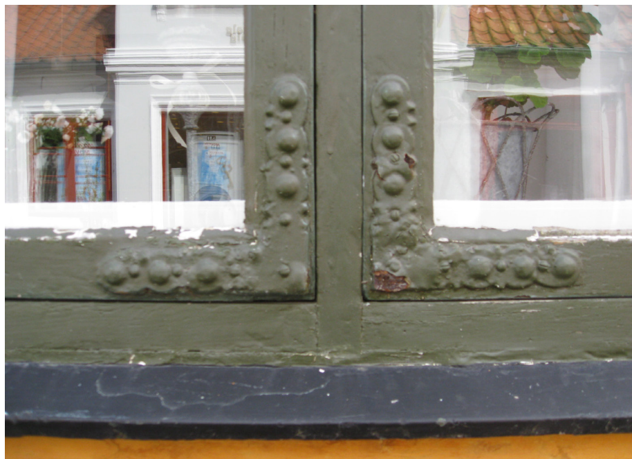
Særligt fine 1700-tals-beslag med svejfede sider og udpunslinger. Selv om vinduesbeslagene har begyndende rust langs kanterne, hvor der åbenbart kan komme vand ind, har dette essesmedede jern en imponerende holdbarhed i kraft af håndsmede-processen i en smedeesse. Her bliver jernet hammerkomprimeret og meget tæt og stærkt, og i øvrigt også helt tyndt. Men fordi det er så tyndt betyder det ikke at der er rustet så meget materiale bort, så det må fornyes. Man afmonterer derfor beslaget forsigtigt, fjerner den løse maling ved en våd, kold afskrabning, og rustbehandler det omhyggeligt (se senere) før det genmonteres på sin gamle plads. Så tager det nemt 250 år mere. Foto: Anne Lindegaard
