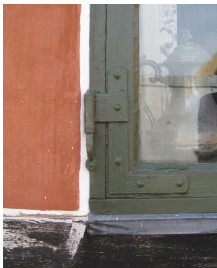
Typisk dansk hjørnebåndshængsel fra efter 1850. De gamle jernbeslag ser tit slemme ud med tykke malingslag, rustskader etc.; men de er ikke uoverkommelige at sætte i stand.
