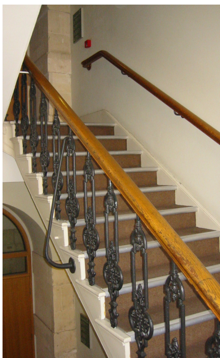
Indstemt trappe med og uden trin. Trinene stemmes ind i en række fordybninger i siden af vangen, udført med stemmejern – deraf navnet. I dag fræses disse på maskine. Heri tilpasses trinene, og de låses med skruer eller dyvler udefra eller de limes til vangerne.
