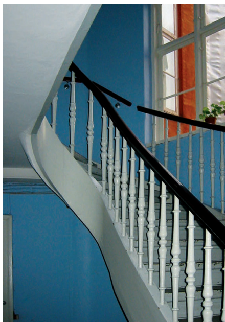
Toløbstrappe i en etageejendom fra midten af 1800-tallet. Normalt vil der være plads til mellemreposer, men ikke her, hvor trinene følger rundingen. Med Københavns Byggelov af 1856 bliver mellemreposer i etagehusenes trapper påbudt.
