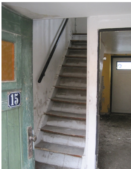
Original ligeløbstrappe i Nyboder (1640'rne). I tværgangen skulle der være adgang til stuelejligheder, haven / gården samt mælkeemand, skraldemand og natmand m.fl., så der er ikke ruttet med pladsen. Men det er en enkel og meget funktionel trappe, der virker helt moderne den dag i dag.
