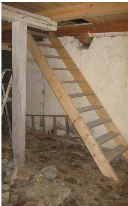
Indstemt trappe med og uden trin. Trinene stemmes ind i en række fordybninger i siden af vangen, udført med stemmejern – deraf navnet. I dag fræses disse på maskine. Heri tilpasses trinene, og de låses med skruer eller dyvler udefra eller de limes til vangerne.
