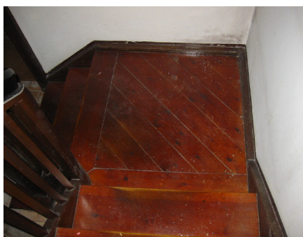
Kvartsvingstrappe. De skrålagte gulvbrædder leder trappegængerens rundt på en pæn måde.
