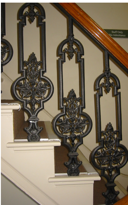
Opsadlet trappe – her med balustre af støbejern.
