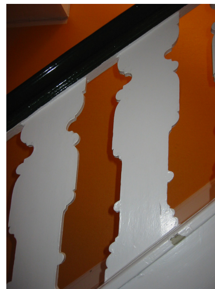
En meget smuk indstemt, barok toløbstrappe fra Christiansfeld. Balustrene er rette, hvor de løber vandret, men vrides skrå og skæve som var de helt bløde, på de skrå løb.
