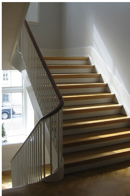
Klassisk toløbstrappe. En smuk og værdig måde at bevæge sig opad i en bygning på. 9-10 trin – pause, mens man svinger eller tager sig et velfortjent pust, og så 9-10 trin igen. Gennem durchsichten og fordi trapper ofte vender ud til vinduer, kan man holde øje med, hvor langt, man er kommet, og hvor langt, man skal endnu. Nedad igen får man samme oplevelse.
