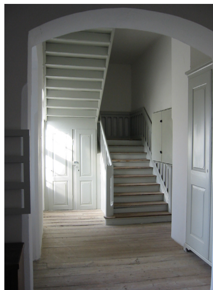
En meget smuk indstemt, barok toløbstrappe fra Christiansfeld. Balustrene er rette, hvor de løber vandret, men vrides skrå og skæve som var de helt bløde, på de skrå løb.
