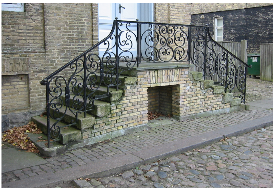
Smuk dobbelttrappe i Christiansfeld. Granittrin på murede vanger i de karakteristiske smalle Flensborgsten. Den lille niche med et murstik over giver trappen en fin lethed, og trappen afrundes af det smukke smedede rokokorækværk.
