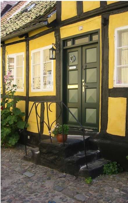
Helt enkle trapper med ganske få stigninger. Opbygget alene af granittrin og uden gelænder – eller med et enkelt af kunst-smedejern.
