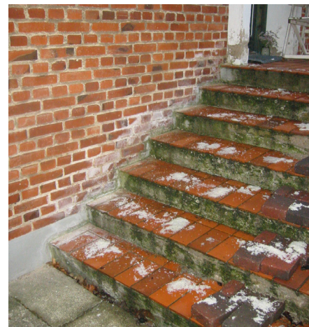
Det er ret slemt at falde på en isglat trappe, så derfor salter mange husejere trappen med kogesalt for at undgå dette. Men saltene angriber sten, mørtel og jern, og de følger endda med, når det sprøjtes op ad murværket. Man kan gruse, uden salt, hvilket er lige så effektivt eller benytte saltformer, der ikke angriber murværket.
