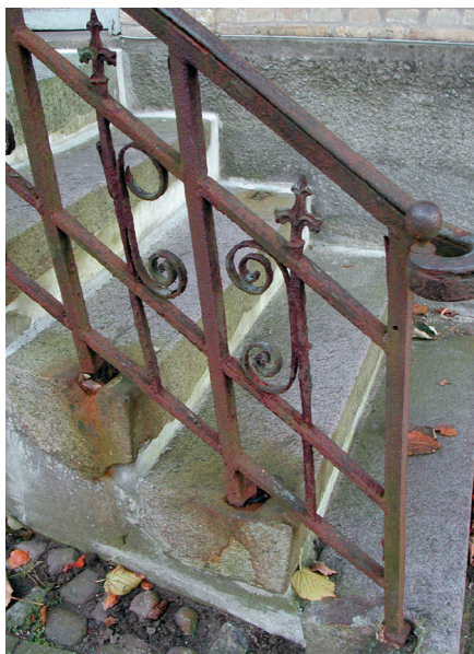
Det er utroligt, at rustne sceptre af jern kan sprænge den stærke granitsten. Men her vinder jernet. Skaderne skyldes ene og alene, at jernet får lov at ruste alt for længe.
