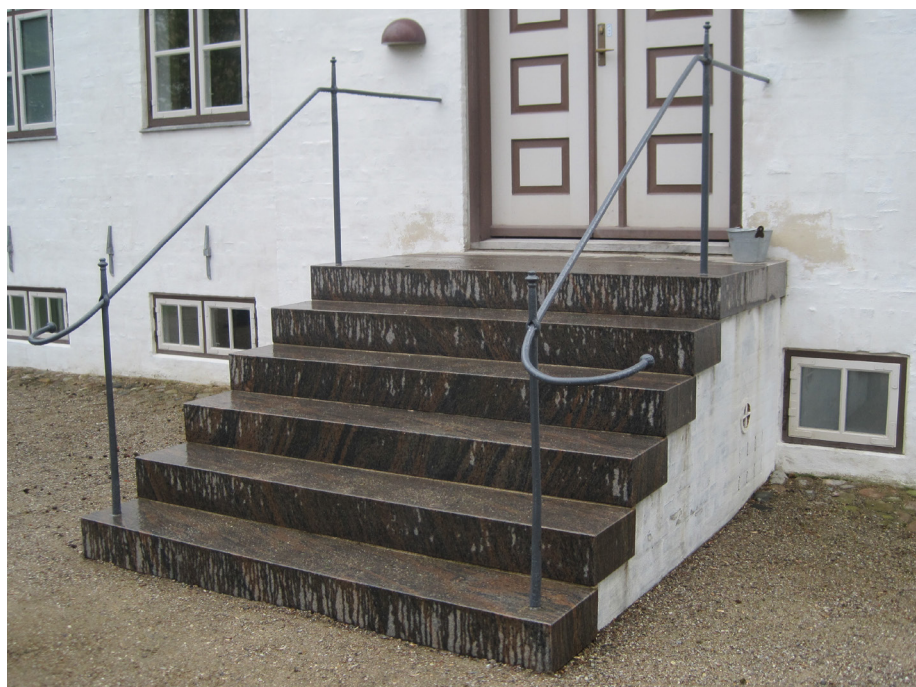
Denne trappe på Nørre Vosborg kunne ikke reddes, så en ny granittrappe måtte bygges. Nu mangler den blot nogle hundrede års slid.
