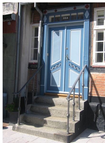
Ved denne trappe skal man holde øje med at jernet ikke rustet, især ved indmuringen i granitten. Støbejerns-sceptrene er for selv at kunne hjælpe med til dette forsynet med en ret gennemtænkt detalje: en lille muffe, der er bredere end selve hullet i granitten, så vandet ikke kan løbe ned i dette.
