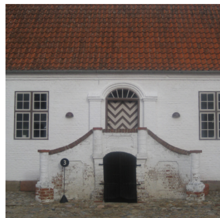
Udvendig muret trappe på Nørre Vosborg, med nedgang til kælderen i samme trappekrop.
