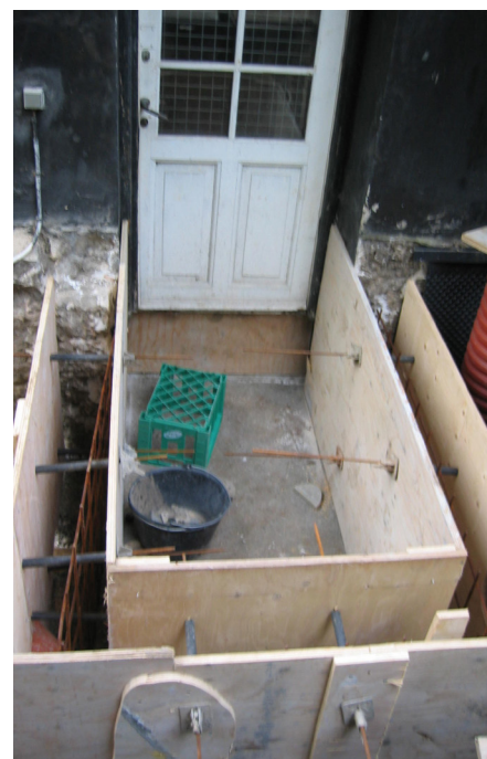
Støbeforskalling til fundamentet for en udvendig kældertrappe. Fundamentet føres til frostfri dybde. Foto: Anne Lindegaard
