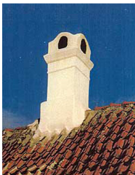
Skorstenspibe med afdækning fra Dragør.
