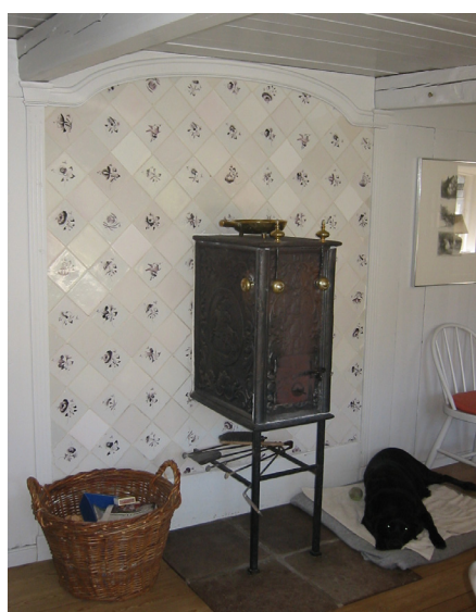
Bilæggerovn. Støbejernsovnen har indfyringshul fra køkkenildstedet og kan derfor ikke åbnes fra stuen, hvilket bevirker, at der heller ikke kommer røg, aske eller støv ud, kun varme, når den er tændt.
