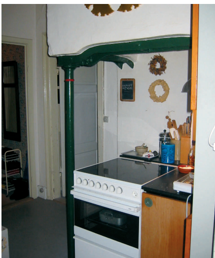
I dette hus har man valgt stadigvæk at lave med i det gamle ildsted – ved at placere det nye moderne komfur her. I andre køkkener har man placeret komfuret et andet sted og gjort ildstedet funktionsdygtigt igen, så man kan fyre et bål op idet og f.eks. grille kød eller andet på det. Det kræver selvfølgelig, at skorstenen kan bruges til dette, hvilket afhænger af dens tilstand m.v., så man skal under alle omstændigheder have en skorstensfejer til at give lov til dette.
