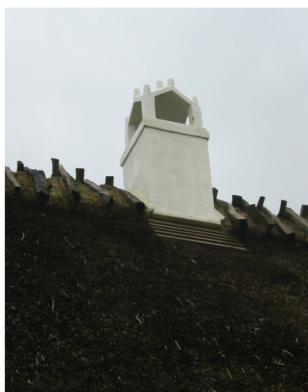
Såkaldt 'pikkelhjem' skorstenspibe fra Sønderjylland og mørtel. For at modvirke
