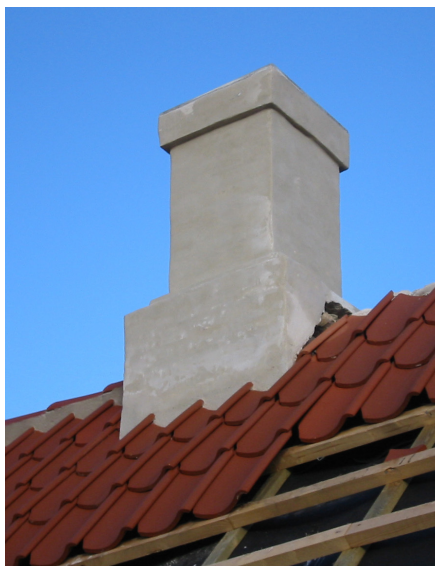
Systemet i en muret inddækning på en skorstenspipe er, at den udkragede sokkel på pipen giver plads til et kraftigt indhak, hvor tagstenenes ender kan lægges ind og fuges ud med mørtel. Det er en smuk, naturlig og også billigere løsning end zinkinddækning
