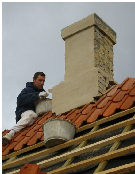
Systemet i en muret inddækning på en skorstenspipe er, at den udkragede sokkel på pipen giver plads til et kraftigt indhak, hvor tagstenenes ender kan lægges ind og fuges ud med mørtel. Det er en smuk, naturlig og også billigere løsning end zinkinddækning
