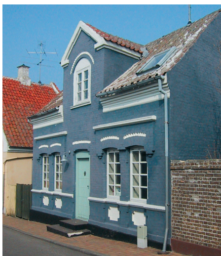
Facade med farvet puds. Gesims, bånd og vinduesspejl er trykket op med hvidtekalk.
