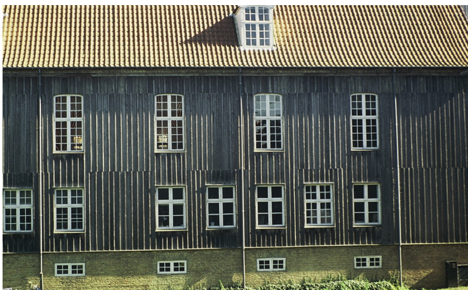
Søstrehuset i Christiansfeld opført 1776 er på den udsatte nordside og på vestgavlen beklædt med brædder – sat uden på det grundmurede hus. Med træ i god kvalitet, godt ventileret og anbragt konstruktivt korrekt som her kan træbeklædninger holde i hundreder af år i Danmark.
