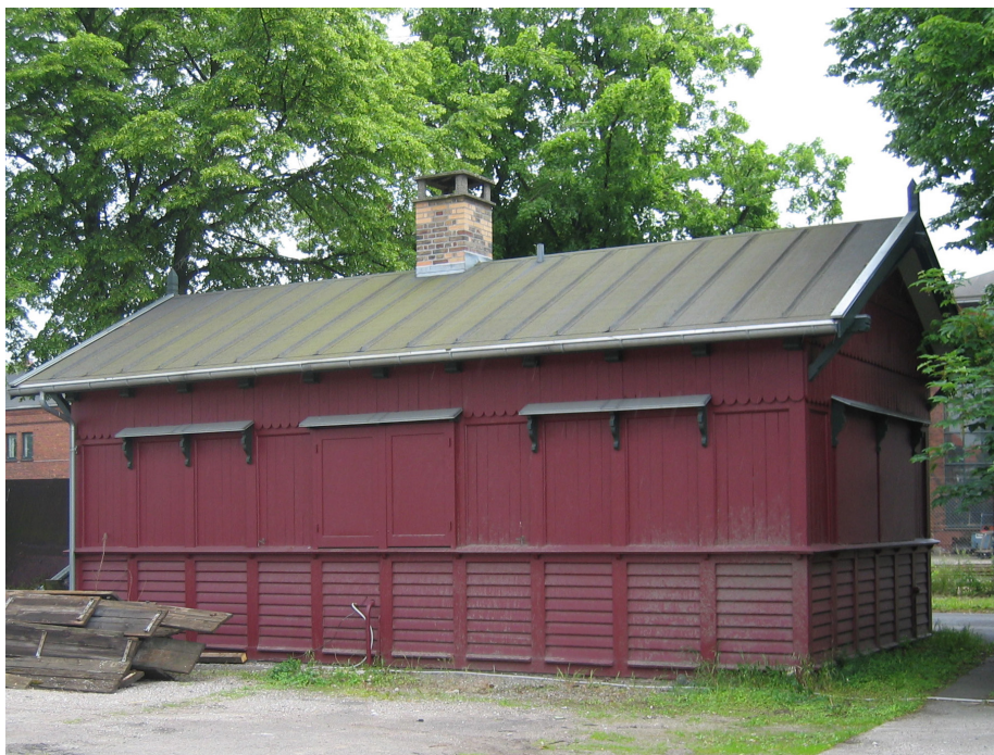
Et smukt eksempel på konstruktiv træbeskyttelse af en træbygning. Et godt paptag med lister, et kraftigt udhæng, vandbrædder over vinduer og underfacaden og selve underfacaden beklædt med klinklagte brædder.
