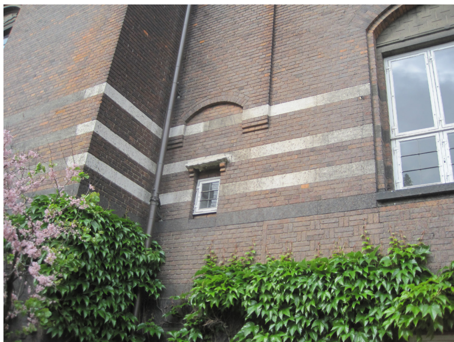
Vandsivning efter 'naturmetoden'. Via et utæt nedløbsrør er der sprøjtet vand ud på murværket, der har opløst den gipsbundne snavs, der bl.a. sidder på de hvide sandstensbånd – så disse igen fremstår hvide.
