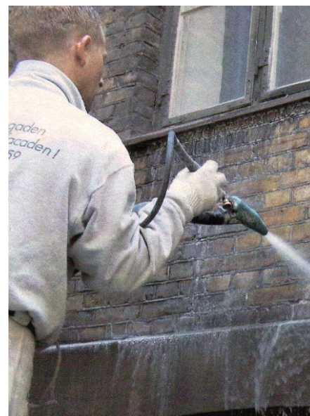
Lavtrykssandblæsning med JOS-metoden.
