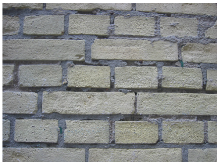
Typisk sandblæst facade, hvor både murstenene og fugerne er kraftigt skadede af for hård behandling. Stenene vil efterfølgende snarere hurtigere og grimmere til.
