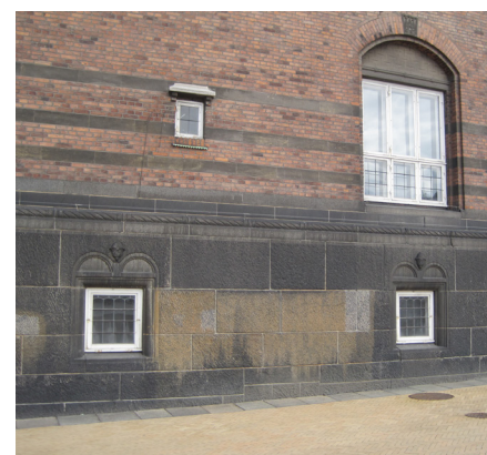
En kemisk afrensning – selv af lidt snavs på et så robust materiale som granit – kan risikere at misfarve bunden, så den originale overflade og farve ikke kan genskabes.
