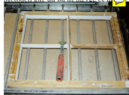
Vådafskrabning af en vinduesramme – uden varme. Varmen ødelægger træet ved at svede olie- og harpiksstoffer uf af veddet.
