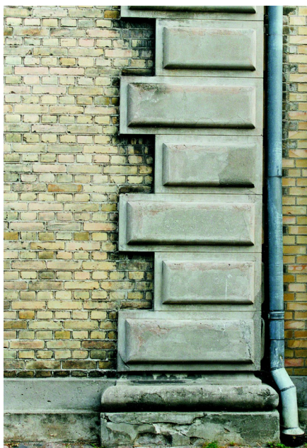
Hus med kvaderhjørne, støbt i Portlandcement. Det snavs, der har lagt sig i de ikke-vandskyllede 'skygger' under kvadrenes fremspring er med til at understrege facadedekorationens karakter. Det ville være synd at afrense disse.
