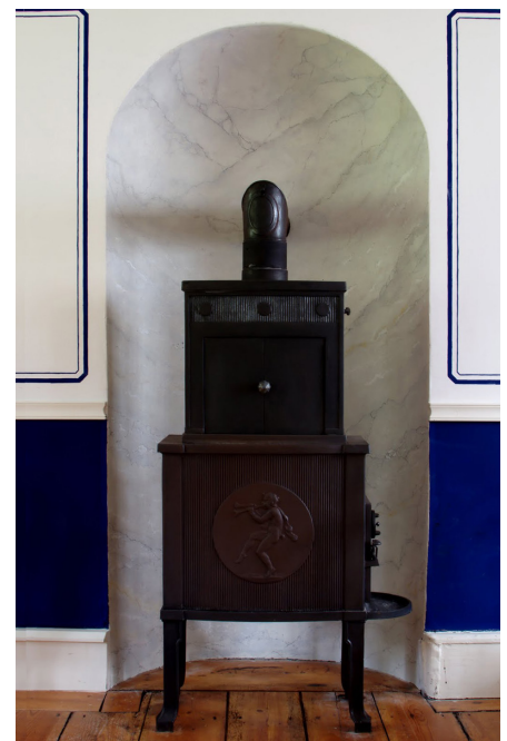
En diskret marmorering på denne trappes stødtrin giver dels trappen et arkitektonisk løft, dels vil de ofte forekommende pletter efter skosnuder falde sammen med marmoreringen. Det samme gælder kakkelovnsnichen, hvor marmoreringen hæver rummet stilmæssigt, men samtidigt slører den tilsoning, der hurtigt kommer her. Så dekorationsmaling kan også have en praktisk, vedligeholdelsesmæssig mening.
