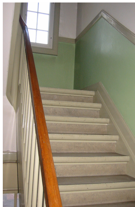
En diskret marmorering på denne trappes stødtrin giver dels trappen et arkitektonisk løft, dels vil de ofte forekommende pletter efter skosnuder falde sammen med marmoreringen. Det samme gælder kakkelovnsnichen, hvor marmoreringen hæver rummet stilmæssigt, men samtidigt slører den tilsoning, der hurtigt kommer her. Så dekorationsmaling kan også have en praktisk, vedligeholdelsesmæssig mening.
