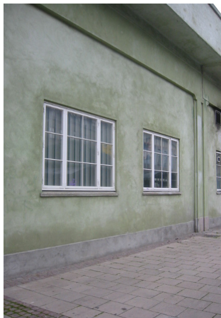
Nørrebro Station i København. Bygget i 1929 og med det meget moderne 'farvede puds' her i grønt, på facaderne. Ved den nyligt udførte reparation har murerne ikke haft det samme styr på at undgå farveskifter og farver, som på det oprindelige farvede puds. Det handler bl.a. om ikke at gnide for meget rundt i materialerne.
