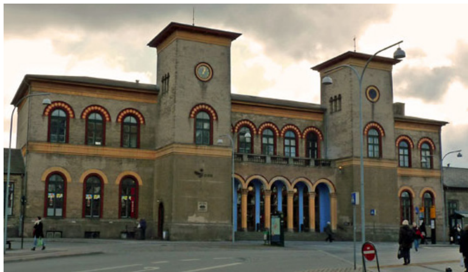
Roskilde Station. De farvede facadedekorationer over vinduer, de vandrette bånd og de blå søjler ved indgangen er malet med temperafarver – for ikke at skade bygningen med plastic eller silikat og fordi kalkfarver ikke kan stå så mættede i farven
