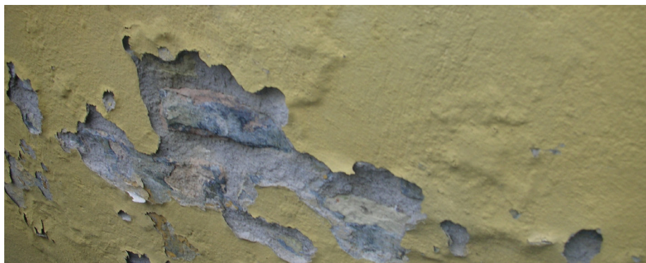
Den anden uheldige egenskab er, at malingsfilmen bliver tættere og tættere, jo kraftigere akrylplastlaget er – dvs. at fugtproblemerne forværres ved flere efterfølgende behandlinger. En række af de tidligere nævnte traditionelle malematerialer bliver ikke nævneværdigt mindre diffusionsåbne ved flere lag.
