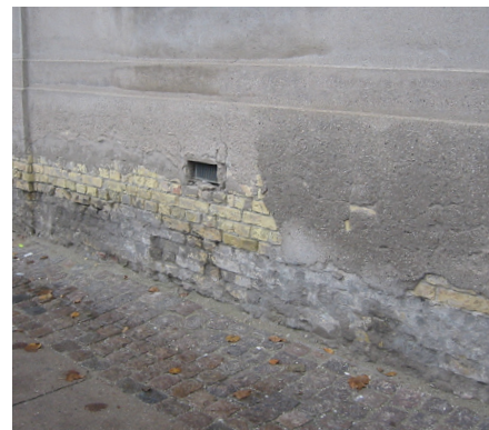
De optagne mursalte i murværket vil ved bestemte lufttryk og temperaturer udkrystallisere på overfladen af murværket eller lige under denne. Under udkrystalliseringen udvider saltene sig ca. 10 gange deres størrelse fra flydende til fast form. Hvis dette sker mange gange, sprænges og pulveriseres både puds, mursten og fuger.
