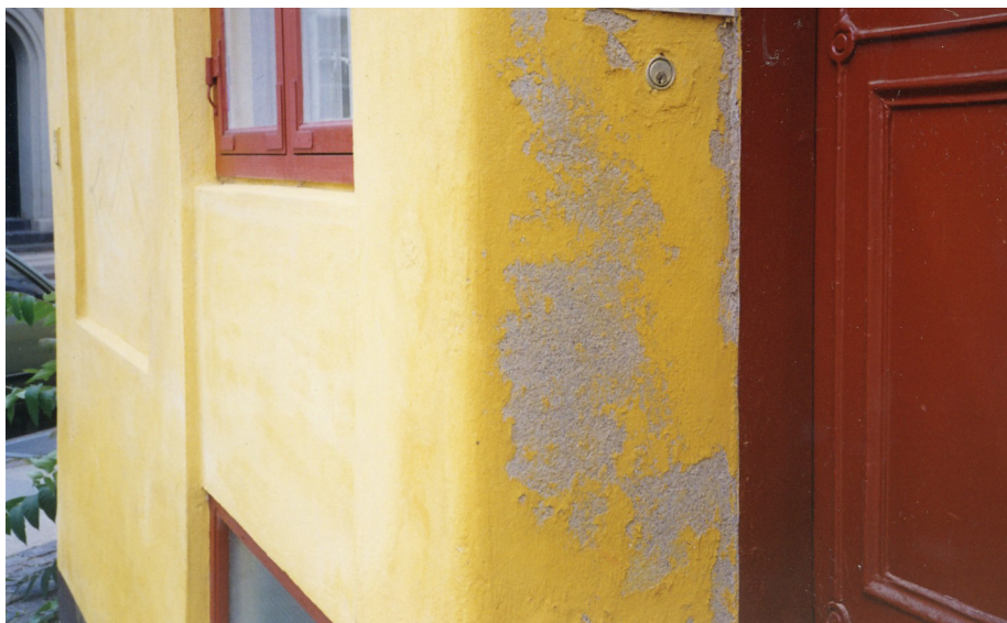
Her ved indgangsdøren, hvor der ofte tøsøltes, løber saltene op i den nye puds og afskyder denne eller den meget åbne gule kalkning. Her skal huset efterfølgende vedligeholdes hvert år – også selv om man holder op med at salte.
