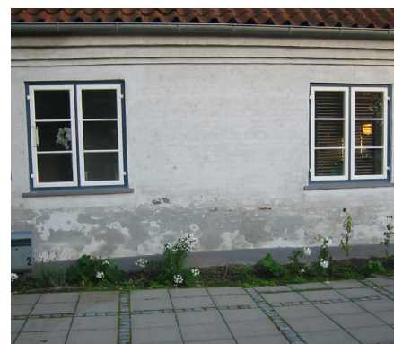
Sokkelpuds på et hus med muret sokkel har til formål at lade mursaltene, fugt og vand fordampe og udkrystallisere inde i sig, hvorved den nedbrydes – og ofrer sig for selve murværket, idet sokkelpuds jo kan skiftes ud ret nemt. Men hvis sokkelpuds får en gang cement, asfalttjære eller tæt plastikmaling, kan fugten og saltene ikke komme ud her, hvorefter de blot løber højere op i murværket, og anretter fugtskader her. Her ligger tilmed indmurede bjælker og derpå gulvbrædder, der kan blive fugtet op og angrebet af råd.
