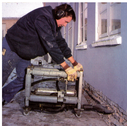
Indpresning af rustfri plader i murværket kan standse den opadstigende grundfugt, der bl.a. medfører hygroskopiske, vandsugende salte.
