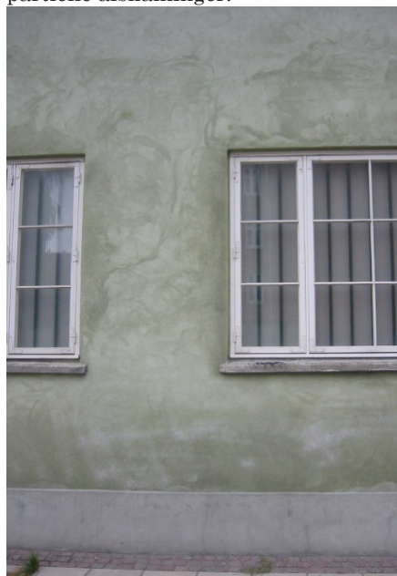
Nørrebro Station i København. Bygget i 1929 og med det meget moderne 'farvede puds' her i grønt, på facaderne. Ved den nyligt udførte reparation har murerne ikke haft det samme styr på at undgå farveskifter og farver, som på det oprindelige farvede puds. Det handler bl.a. om ikke at gnide for meget rundt i materialerne.
