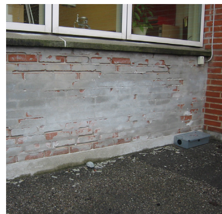
En alt for cementsholdig tyndpuds (filtning) på helt nyt murværk bevirker, at fugten ikke kan komme ud gennem pudsens og derfor først presser sig ud gennem fugerne og derefter skyder skaller af murstenene.
