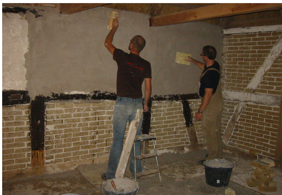
Pudsning af overvægge i et bindingsværkshus. Der er slået kyllingenet på tømmeret, for at pudsen skal hænge fast på dette. Der pudsnes med en ren luftkalkmørtel.
