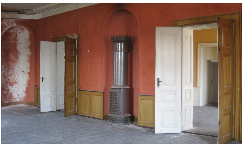
Limfarvede overvægge, limfarvet loft og linoiemalede, ådrede døre og paneler. Kastrup Værk i Kastrup, opført 1751, men denne sal er i klassicistisk stil fra ca. 1830.
