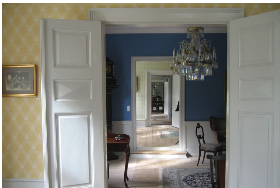
De indvendige vægge i murede huse kunne før i tiden være pudsede og limfarvede, pudsede og tapetserede, som her, eller de kunne have udspændte hessiantapeter, der var krideret og malet.
