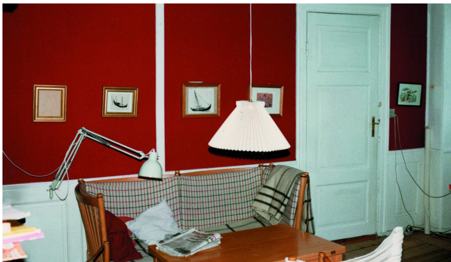
Hvis gipsplader opsættes med trælister over pladernes samling, ligner de næsten lærredstapeter. Papiroverfladen er perfekt at male med limfarve på.
