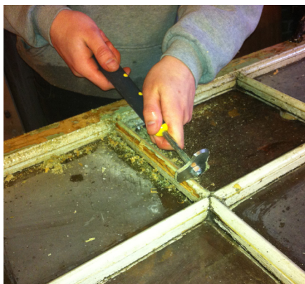
Ved afskrabningen skal man være meget forsigtig med ikke at skramme eller skæmme eventuelle profileringer i vinduer, døre, indfatninger, paneler m.v.
