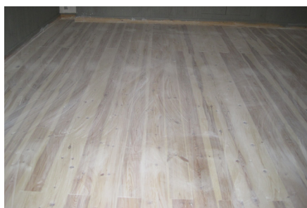
Her ses det færdigbehandlede gulv med det smukke hvidlige skær, der både skyldes kalkens hvidhed i hærdet form og dens basiske virkning på træet. Læg til sammenligning mærke til det ubehandlede fodpanels langt mere gule farve.
