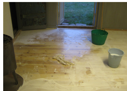
Kalk og sæbeblandingen er påført og tørrer op som et hvidt lag. Umiddelbart efter tørringen vaskes det hvide lag af med sæbespånere i varmt vand. Man vil lægge mærke til, hvordan vandet perler oven på det hvide lag.
