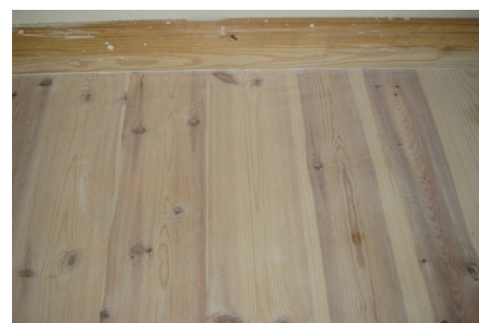
Her ses det færdigbehandlede gulv med det smukke hvidlige skær, der både skyldes kalkens hvidhed i hærdet form og dens basiske virkning på træet. Læg til sammenligning mærke til det ubehandlede fodpanels langt mere gule farve.
