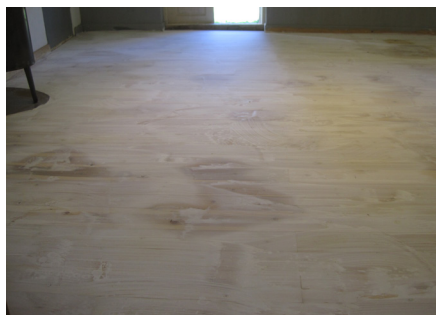
Kalk og sæbeblandingen er påført og tørrer op som et hvidt lag. Umiddelbart efter tørringen vaskes det hvide lag af med sæbespånere i varmt vand. Man vil lægge mærke til, hvordan vandet perler oven på det hvide lag.
