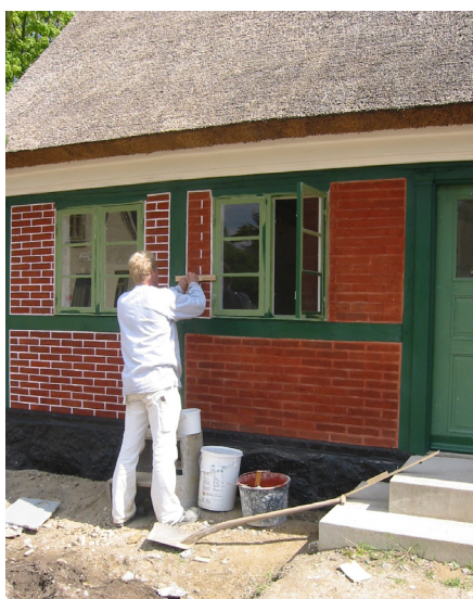
Kalkning med rød kalkfarve. Her bliver fugerne ydermere trukket op med hvidtekalk, så det pudsede murværk, der måske består af soltørrede lersten, kommer til at ligne det langt mere prestigefulde murværk med brændte mursten.
