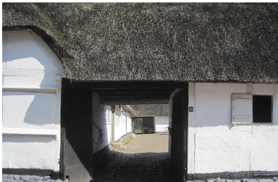
Hvidtekalk og kalkfarver lyser kraftigt i solskinnet og understreger dermed de karakterfulde slagskygger, der kommer på ældre bygninger fra udhæng og andre fremspring.
