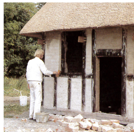
Klargøring til kalkning. Murværket er repareret, og alle huller og revner er stoppet ud med kalkmørtel. Efter forvanding grundes bunden med kalkvand.
