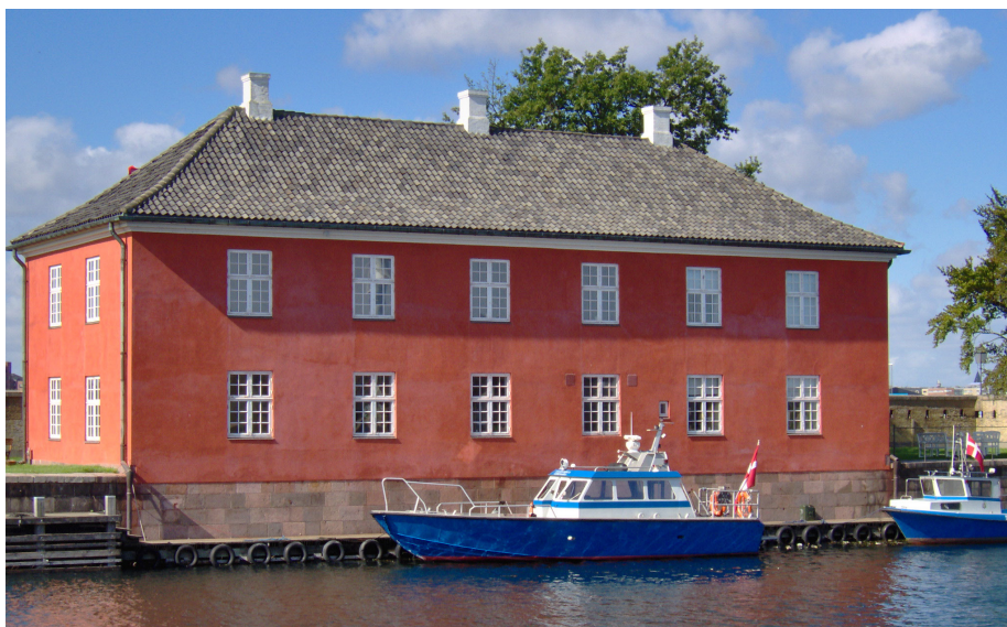
Både hvidtekalk og kalkfarver repræsenterer den smukkeste, billigste og teknisk bedste overfladebehandling, til murede og pudsede huse, ikke mindst sat smagfuldt sammen – noget bl.a. Forsvaret har udnyttet, her på Trekrøner Søfort. Foto: Rønnow Arkitekter a/s
