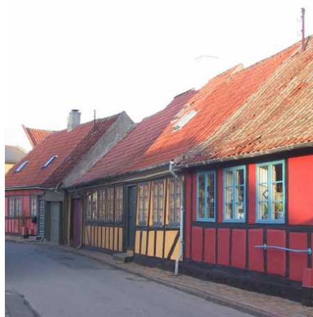
Gade i Kerteminde med kalkede huse i forskellige farver
