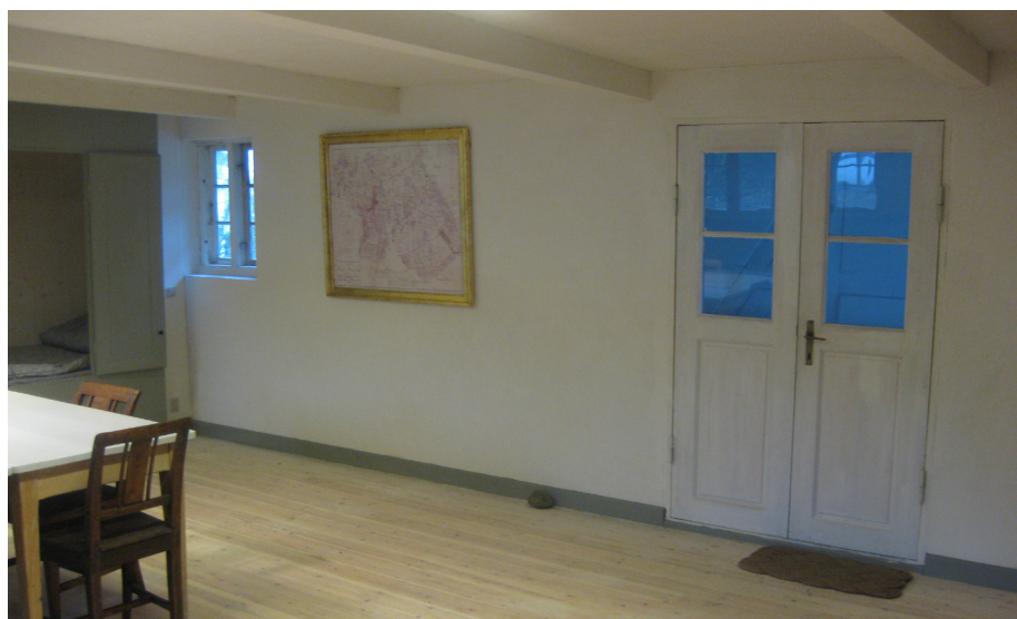
Pudset væg, malet med hvid kaseinfarve. Efter 2-3 strygninger er farven fuldt dækkende og står med sin smukke kalkagtige overflade og lyser i selv ret mørke rum.
