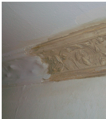
Afrensning af en overplastret loftsstuk er et møjsommeligt arbejde, men fornøjelsen ved at se den afrensede og ny-limfarvede stuk er tilsvarende stor.
