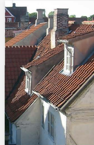
By- og Bygningsundersø gelser
