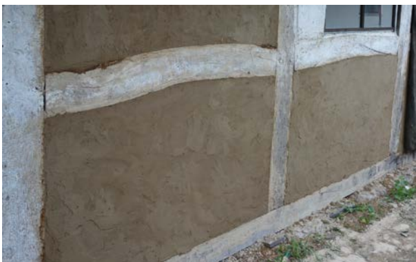
Rigtigt: Behold de gamle lertavl – eller lav nye, hvis de skal udskiftes.
