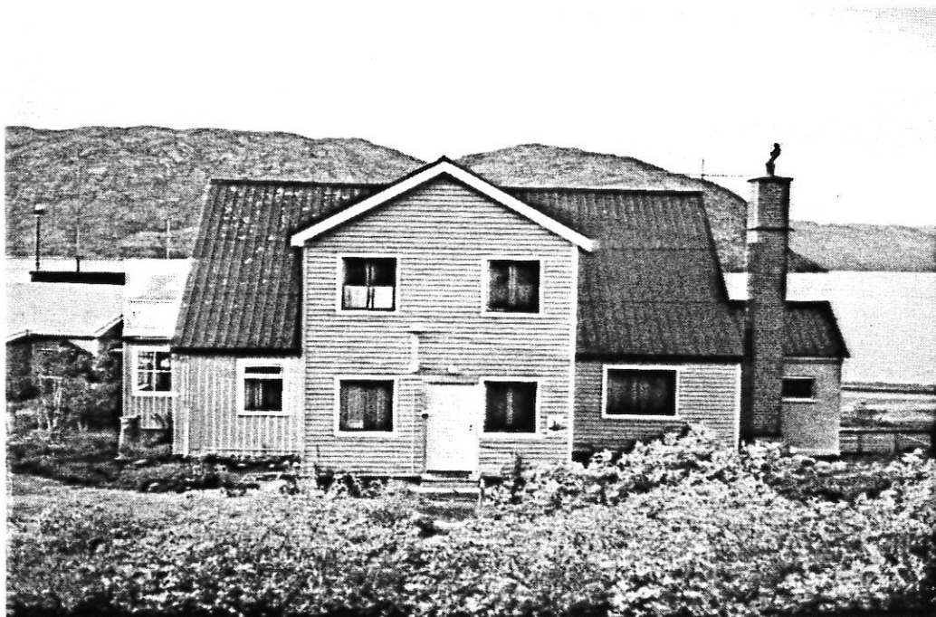
Tidl. kontrollørbolig, nuværende sygehus set fra syd. 1981 Indgangspartiet påført 1941
