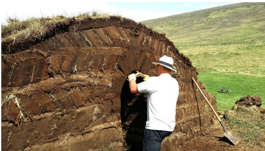
Byggemuseet i Glaumbær ved Skagafjord i Nordisland er bl.a. i gang med at rekonstruere og genopføre den nu nedrevne tørvegård Tyrfingsstaðir, efter opmålingstegningerne fra 1975 og 1976 fra de to arkitektskoler i Danmark. Fra: byggdasafn@skagafjordur.is
